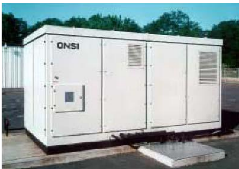
Σχήμα 2.1: Σταθμός παραγωγής ηλεκτρικής ενέργειας με κυψέλες καυσίμου [11]
