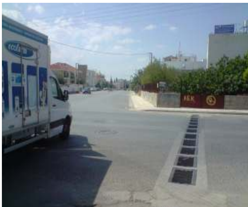
Εικόνα 4.9: Ανατολική άποψη του Κόμβου, στους Θρακομακεδόνες
