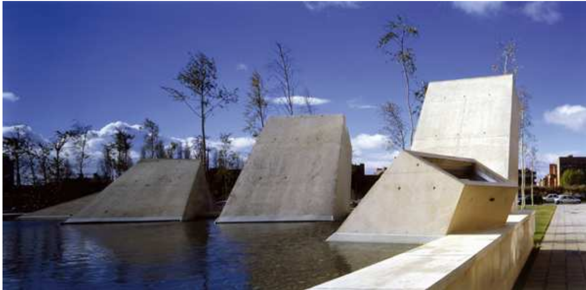
Εικόνα 1.5. Εξωτερικός χώρος υπόγειας κατασκευής στην Ισπανία.
