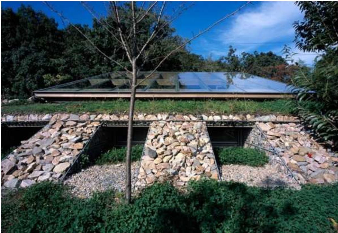
Εικόνα 5.6. Ανοίγματα στην οροφή του παρέχουν φωτισμό και αερισμό. Πηγή: "Interactive Floorplan: Base Valley House, Japan | Architecture | Wallpaper* Magazine." Wallpaper.com | Home | Wallpaper* Magazine. Web. 05 Sept. 2010. < http://www.wallpaper.com >.
