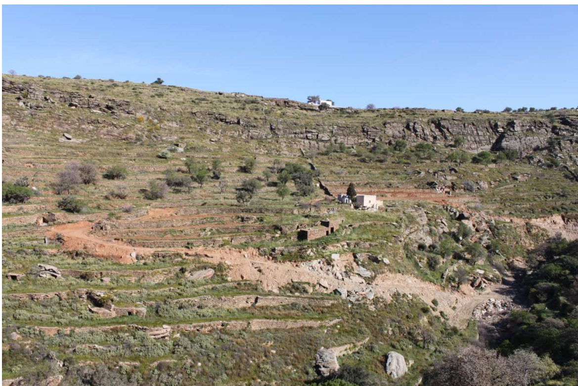
Εικόνα 5.4. Άποψη της περιοχής εγκατάστασης της κατασκευής
