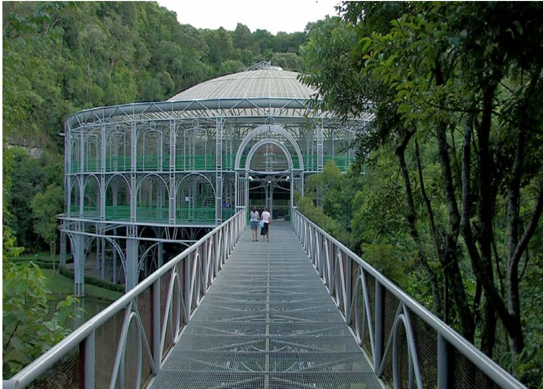
Εικόνα 4.11: Η γέφυρα που οδηγεί στο θέατρο
