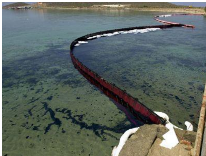
Σχήμα 7.1: Πλωτά φράγματα συγκέντρωσης των πετρελαιοειδών.
