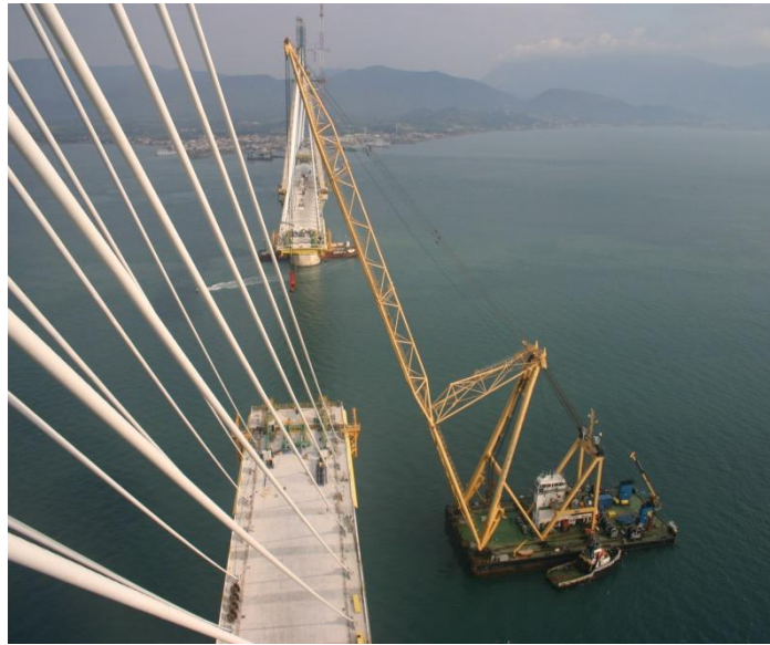
Σχήμα 2.3: Το sheer leg Tacklift 7 κατά την κατασκευή της γέφυρας Ρίου-Αντιρίου.
