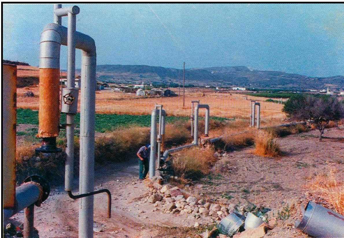
Σχήμα 4.16 Φωτογραφία του αγωγού επανεισαγωγής της Μήλου (Πηγή: Φοτίκας-Ανδρίτσος, 2004)
