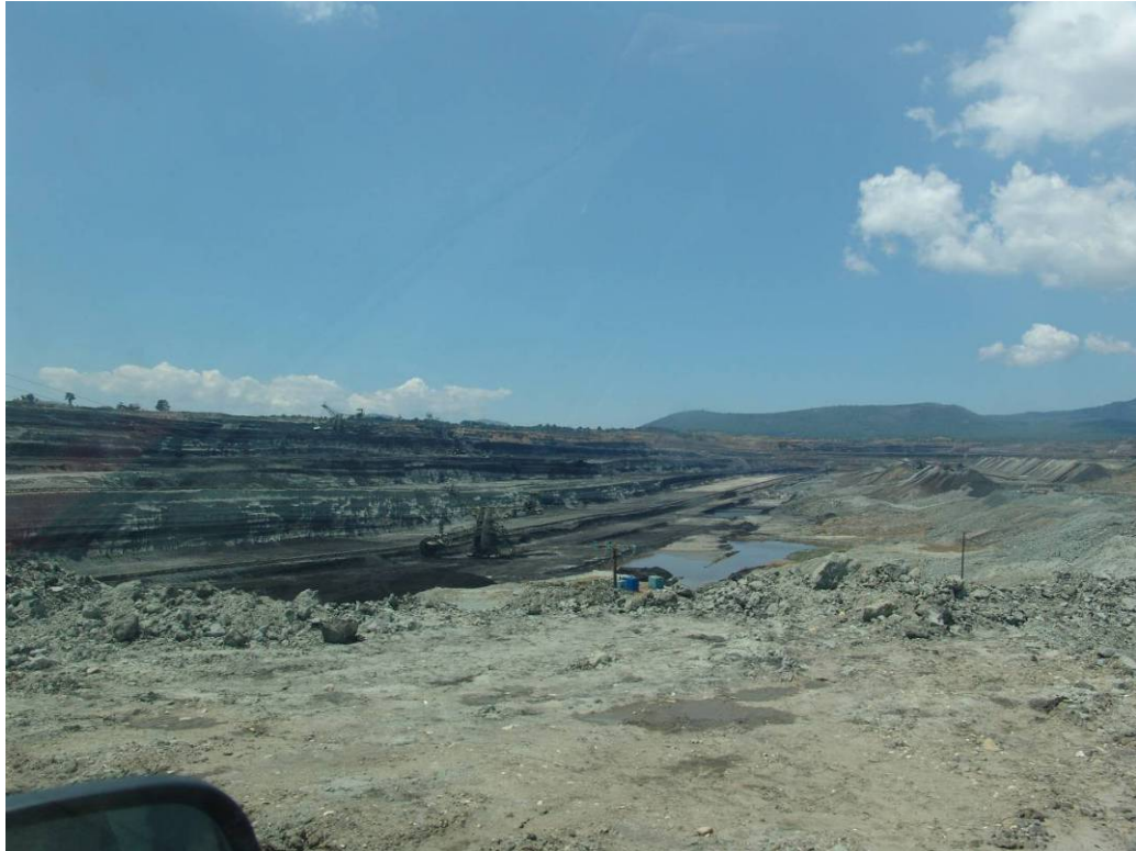
Εικόνα 10: Ορυχείο Μαραθούσας Διακρίνεται στο βάθος το αντλιοστάσιο.
