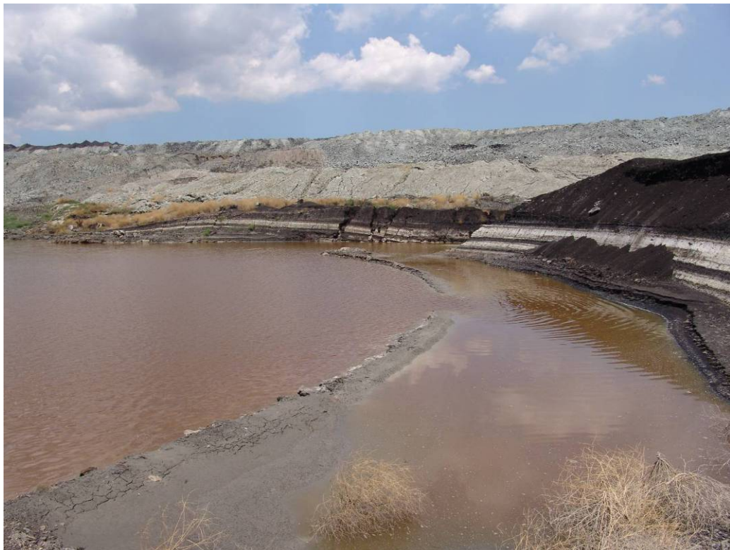
Εικόνα 11: Αντλιοστάσιο στο ορυχείο Χωρεμίου
