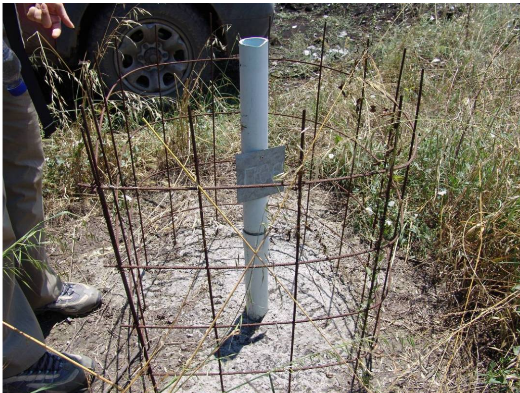
Εικόνα 14: Πιεζόμετρο στο ορυχείο Θωκνίας.
