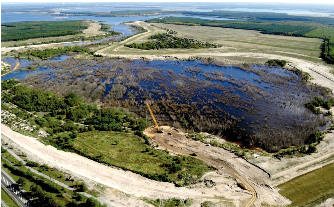
Εικόνα 1-2: Άποψη του ορυχείου Restloch Sedlitz κατά τη διάρκεια της δημιουργίας λίμνης Fotograf: Radke, Peter (von Fa. agreement für LMBV) : 2009
