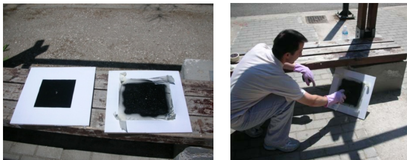
Εικόνα 7-6: Προετοιμασία κινητών στόχων
