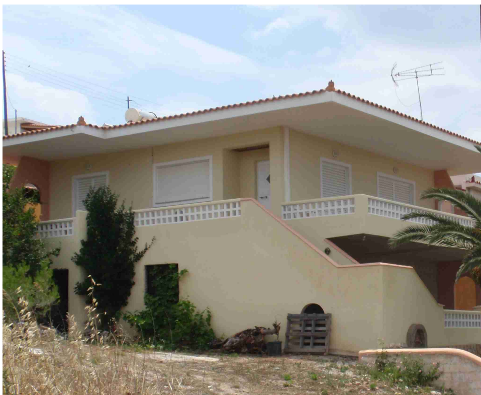
Εικόνα 4.11 . Φωτογραφία κτίσματος που απεικονίζεται στο παραπάνω διάγραμμα
