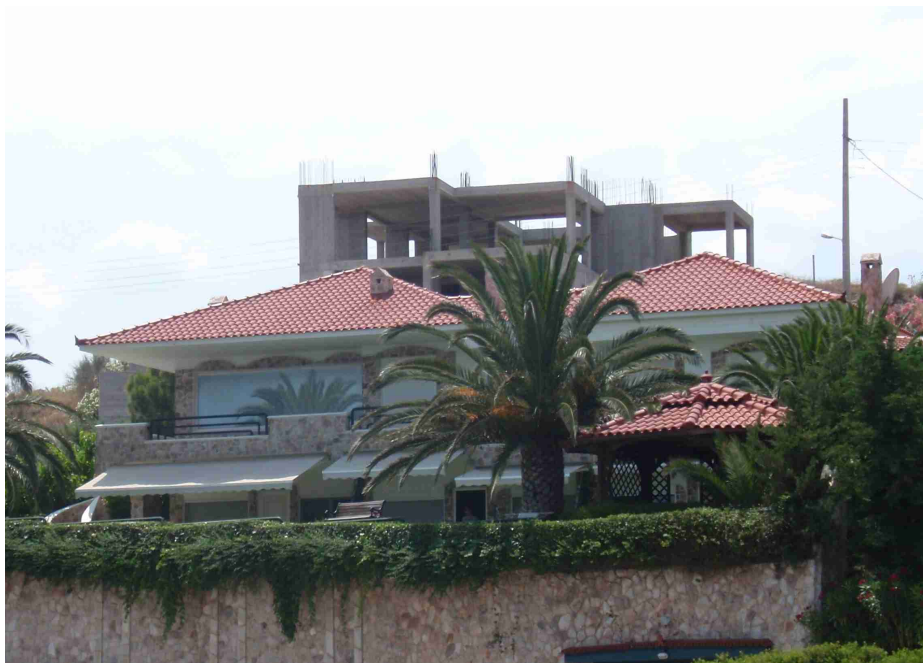
Εικόνα 4.12 . Φωτογραφία κτιρίου που απεικονίζεται στο παραπάνω διάγραμμα
