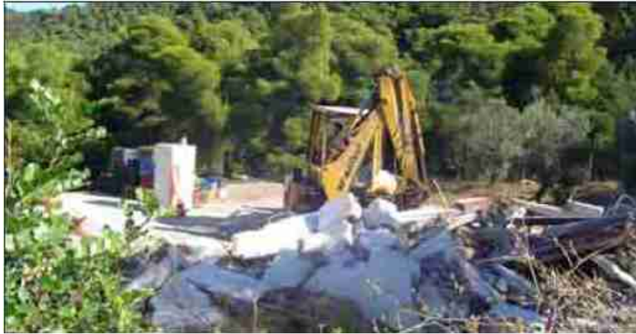
Εικόνα 2.3. Κατεδάφιση αυθαιρέτου σε δασική περιοχή (Πηγή: Πότσιου, 2010)
