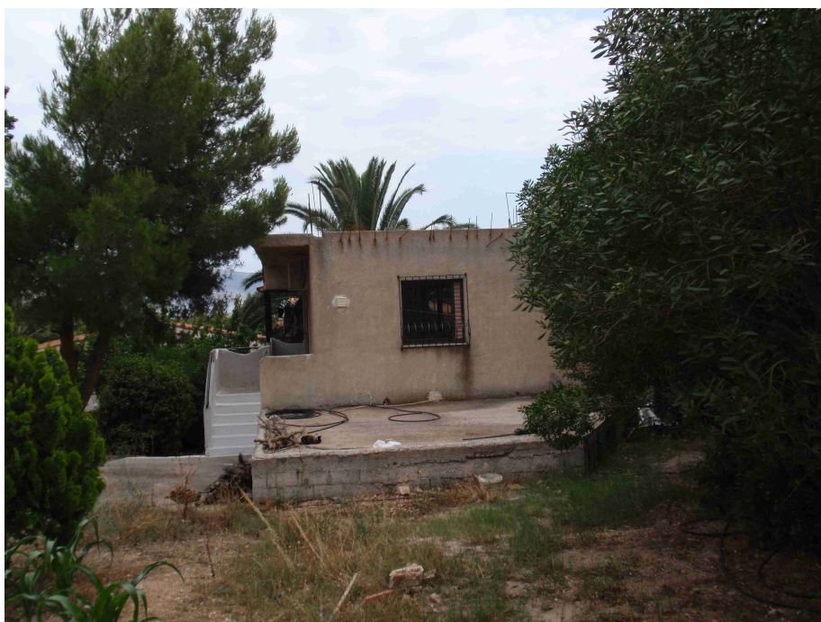
Εικόνα 4.13 . Φωτογραφία κτίσματος που απεικονίζεται στο παραπάνω διάγραμμα
