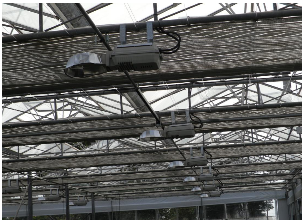
Εικόνα 8: Λαμπτήρας φωτισμού σε συνδυασμό με σύστημα θερμοκουρτίνας για σκίαση και θερμομόνωση στην κορυφή. ( www.meidanis.com.gr )
