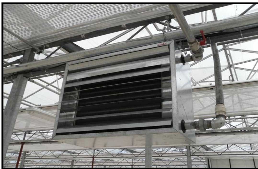
Εικόνα 4: Αξονικό αερόθερμο κρεμασμένο από την οροφή του θερμοκηπίου ( www.meidanis.com.gr )
