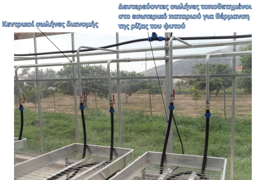
Εικόνα 6: Τοποθέτηση των δευτερευόντων σωλήνων μέσα στο ειδικά διαμορφωμένο πατάρι για θέρμανση των φυτών στη ρίζα και ελαχιστοποίηση των απωλειών.
