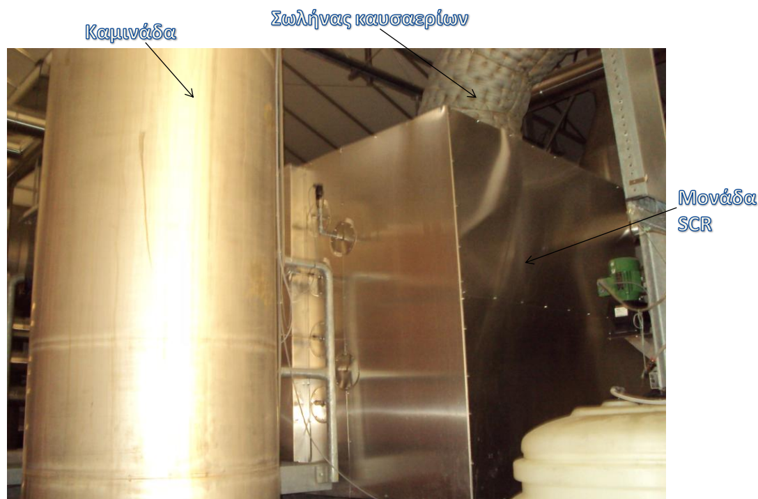
Εικόνα 24: Μονάδα SCR ( www.dgsa.com.gr )
