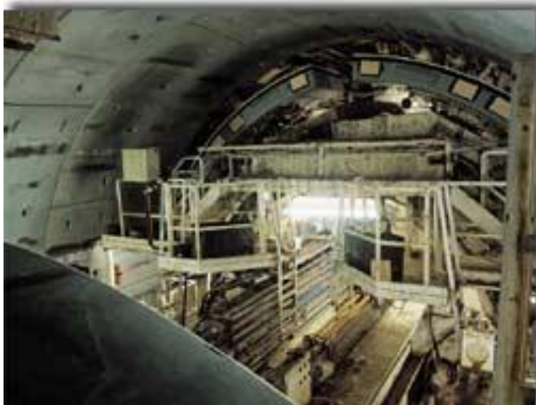
Εικόνα 4-6: Τοποθέτηση προκατασκευασμένων στοιχείων
