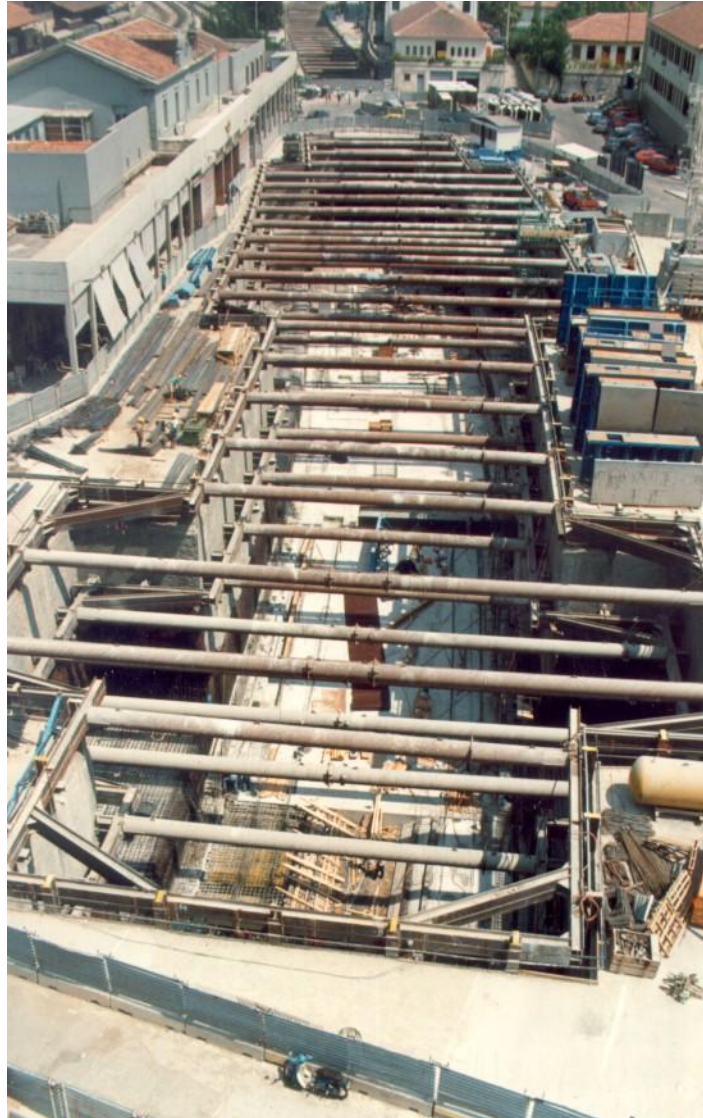
Εικόνα 4-1: Τοποθέτηση αντηρίδων για την υποστήριξη της εκσκαφής
