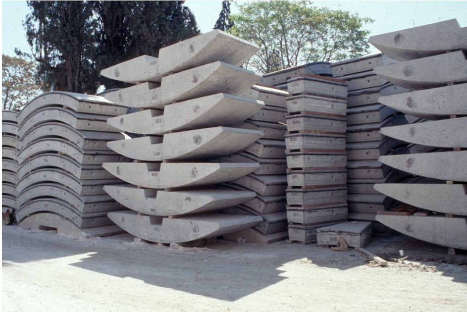
Εικόνα 4-7: Προκατασκευασμένα στοιχεία μόνιμης επένδυσης
