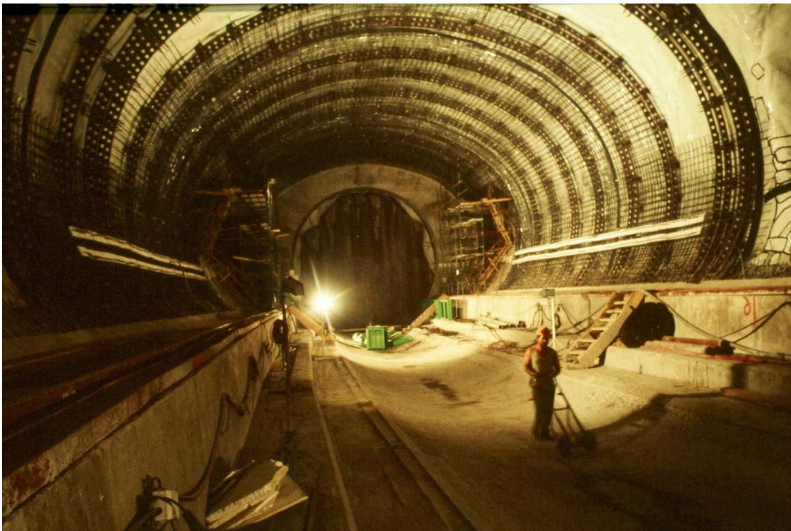
Εικόνα 4-2: Τοποθέτηση τελικής επένδυσης με τη μέθοδο NATM, Αττικό Μετρό Α.Ε.
