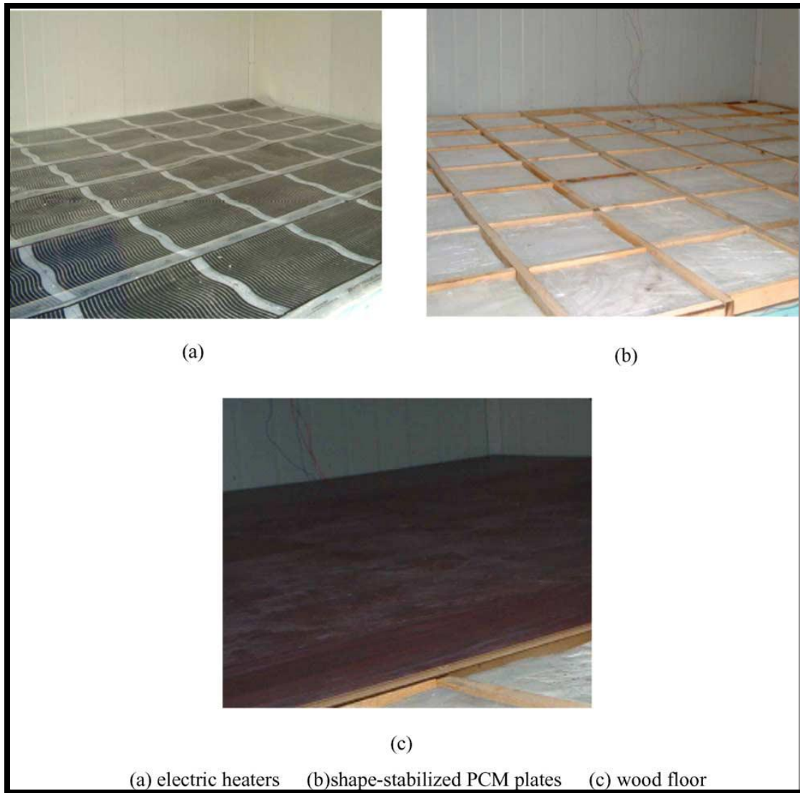
Εικόνα 7.2.3 Φωτογραφίες από τη δομή του συστήματος.
