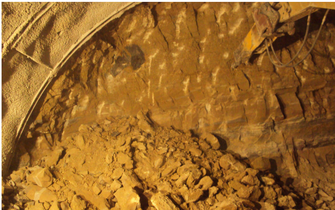
Εικόνα 5.1: Εκσκαφή της άνω ημιδιατομής της σήραγγας 11 των Μαύρων Λιθαριών (Κατηγορία M_{III} ).
