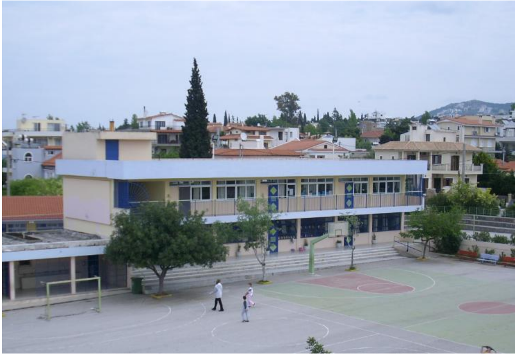
Εικόνα4: Νότια όψη κτηρίου Β
