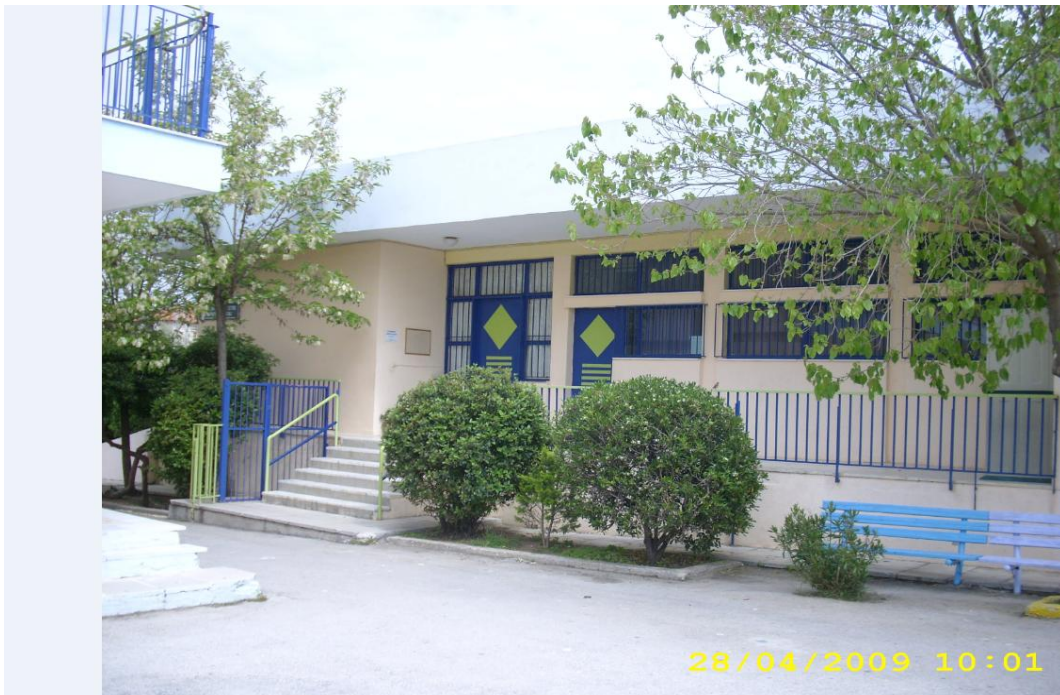
Εικόνα 5: Ανατολική όψη κτηρίου Γ
