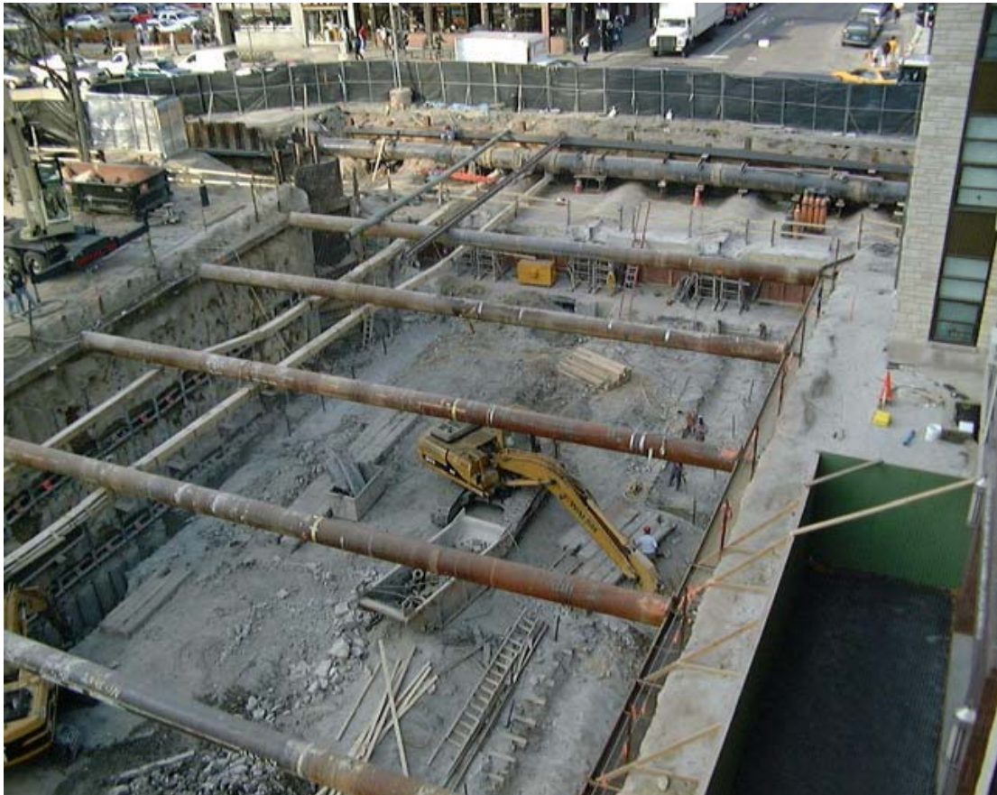
Σχ. 23: Άποψη της εκσκαφής από την οροφή του Frances Xavier Warde School
