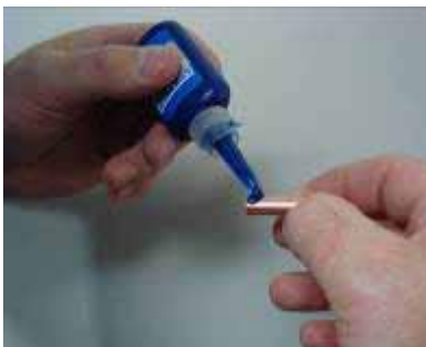
Το Lokring κλείνει τις ατέλειες στην επιφάνεια του σωλήνα
