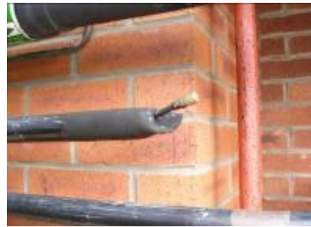
Μια πρόχειρα τοποθετημένη βαλβίδα Schrader στο τέλος ενός ανεπαρκώς στεγανωμένου χαλκοσωλήνα
