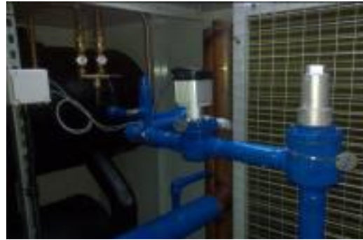
Βαλβίδα διακοπής με πώμα στα δεξιά της φωτογραφίας, και το κοντρόλ ενεργοποίησης στα αριστερά
