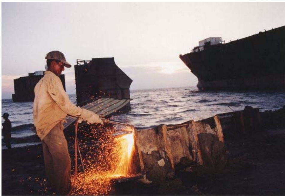
Εικόνα 2.4 Κοπή υποτομέα πλοίου υπό διάλυση σε διαλυτήριο στην Ινδία
