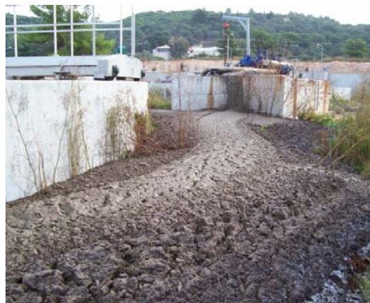
Εικόνα 2.2: Διαφορετικές εγκαταστάσεις επεξεργασίας λυμάτων στην Ελλάδα που παρουσιάζουν έντονο πρόβλημα νηματοειδούς αφρισμού. Στις φωτογραφίες φαίνεται ο αφρός που έχει υπερχειλίσει τις δεξαμενές δευτεροβάθμιας επεξεργασίας δημιουργώντας επικίνδυνες εργασιακές συνθήκες.
