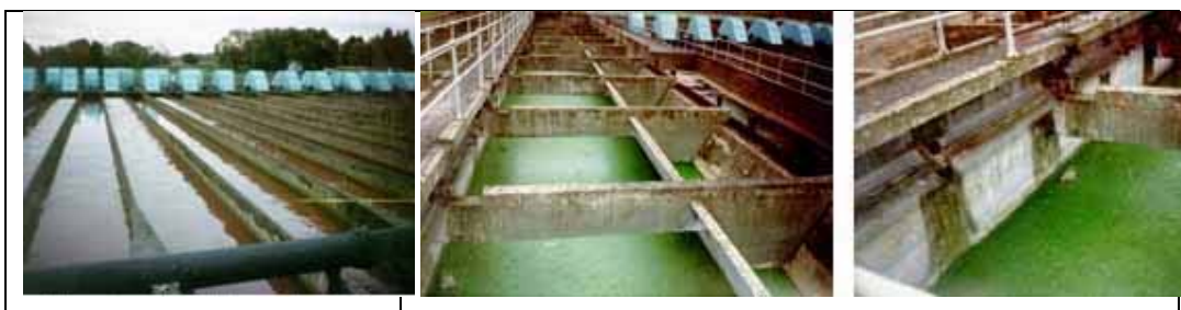
Εικόνα 2.1: Σύστημα ενεργού ιλύος σε εγκαταστάσεις επεξεργασίας λυμάτων στο Stockport της Αγγλίας στις πρώτες εφαρμογές του κατά τη χρονική περίοδο α) 1924-1927, β) και γ) 1935-1940
