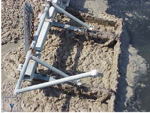
Εικόνα 2.6: Νηματοειδής αφρισμός με διαφορετικά χαρακτηριστικά σε επιμέρους στάδια της επεξεργασίας ενεργού ιλύος. Οι εικόνες α, β είναι από τις δεξαμενές βιολογικής επεξεργασίας, η α από το ανοξικό διαμέρισμα και η β από το διαμέρισμα αερισμού. Η εικόνα γ είναι από τη δεξαμενή καθίζησης και δείχνει το σύστημα συλλογής επιπλεόντων ενώ η εικόνα δ απεικονίζει το φρεάτιο συλλογής τους.
