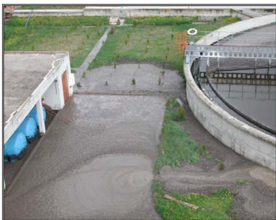
Εικόνα 2.2: Διαφορετικές εγκαταστάσεις επεξεργασίας λυμάτων στην Ελλάδα που παρουσιάζουν έντονο πρόβλημα νηματοειδούς αφρισμού. Στις φωτογραφίες φαίνεται ο αφρός που έχει υπερχειλίσει τις δεξαμενές δευτεροβάθμιας επεξεργασίας δημιουργώντας επικίνδυνες εργασιακές συνθήκες.
