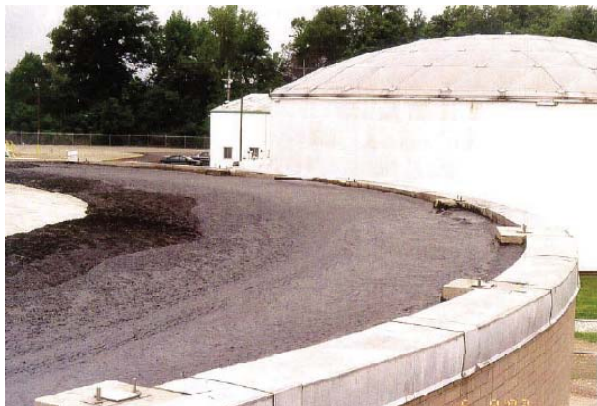
Εικόνα 2.3: Πρόβλημα νηματοειδούς αφρισμού σε αναερόβιο χωνευτή. Στη φωτογραφία φαίνεται αφρός που έχει υπερχειλίσει από το σύστημα συλλογής βιοαερίου του χωνευτή και έχει καλύψει την εξωτερική επιφάνεια της κεφαλής του.
