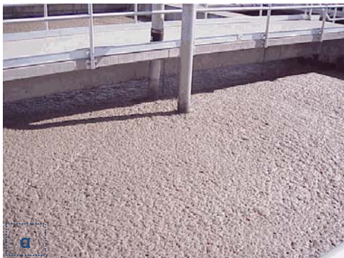
Εικόνα 2.6: Νηματοειδής αφρισμός με διαφορετικά χαρακτηριστικά σε επιμέρους στάδια της επεξεργασίας ενεργού ιλύος. Οι εικόνες α, β είναι από τις δεξαμενές βιολογικής επεξεργασίας, η α από το ανοξικό διαμέρισμα και η β από το διαμέρισμα αερισμού.
