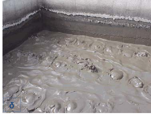
Εικόνα 2.6: Νηματοειδής αφρισμός με διαφορετικά χαρακτηριστικά σε επιμέρους στάδια της επεξεργασίας ενεργού ιλύος. Οι εικόνες α, β είναι από τις δεξαμενές βιολογικής επεξεργασίας, η α από το ανοξικό διαμέρισμα και η β από το διαμέρισμα αερισμού. Η εικόνα γ είναι από τη δεξαμενή καθίζησης και δείχνει το σύστημα συλλογής επιπλεόντων ενώ η εικόνα δ απεικονίζει το φρεάτιο συλλογής τους.
