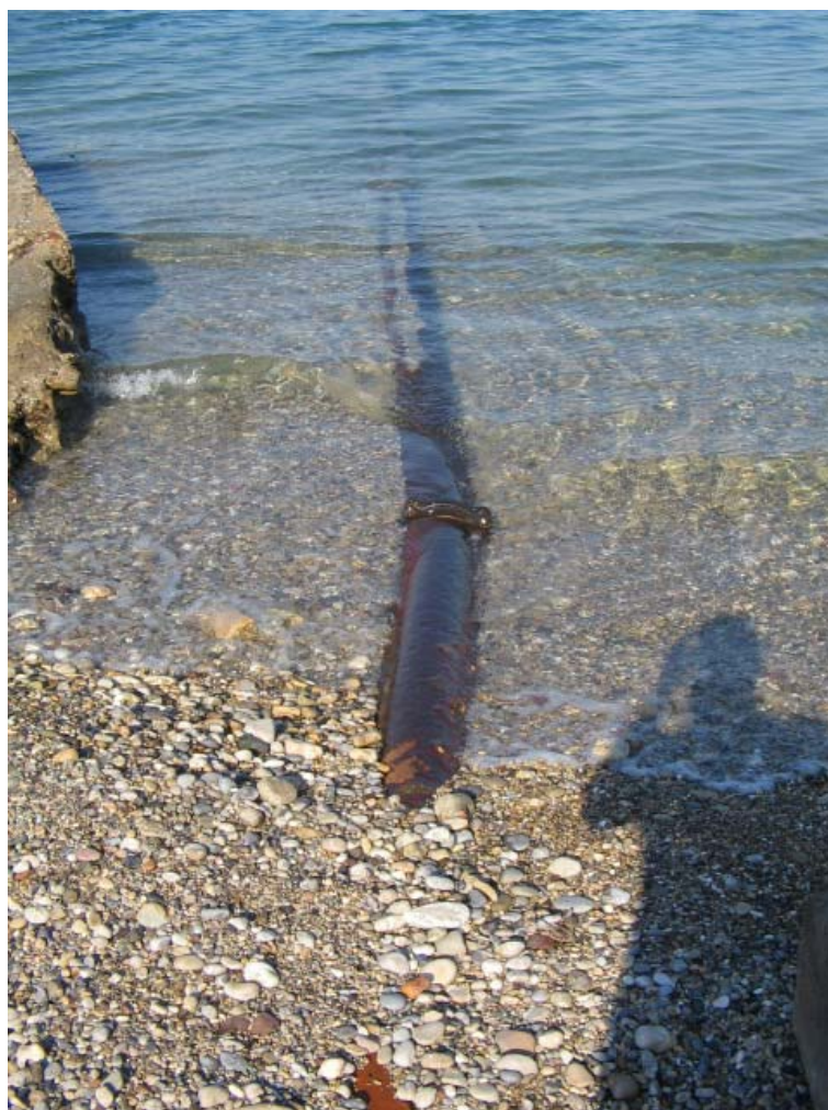
αγωγός αποβλήτων χαρτοβιομηχανίας (Βέλο Κορινθίας)
