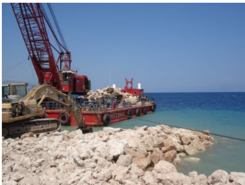
Κατασκευή κυματοθραύστη στις εκβολές του Ασωπού.
