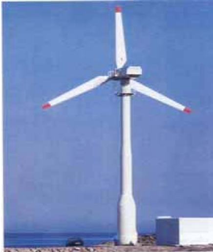
Σχήμα 2.5 Ανεμογεννήτριες με σωληνωτό χαλύβδινο πύργο (αριστερά) και δικτυωτό πύργο (δεξιά). (Πηγή: ΚΑΠΕ, “Οδηγός Τεχνολογιών Ηλεκτροπαραγωγής από ΑΠΕ”)
