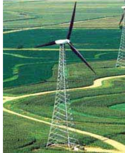
Σχήμα 2.5 Ανεμογεννήτριες με σωληνωτό χαλύβδινο πύργο (αριστερά) και δικτυωτό πύργο (δεξιά). (Πηγή: ΚΑΠΕ, “Οδηγός Τεχνολογιών Ηλεκτροπαραγωγής από ΑΠΕ”)
