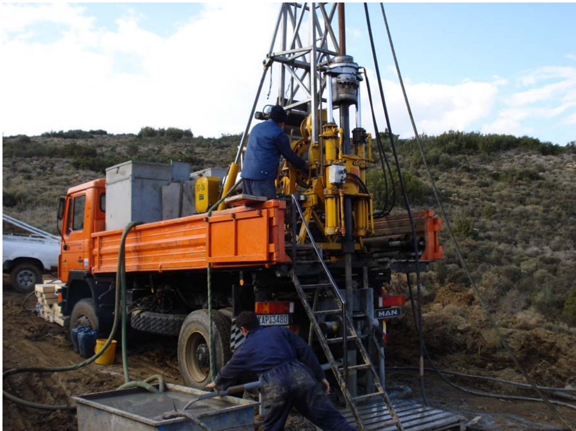
Εκτέλεση Γεώτρησης BT1-203
