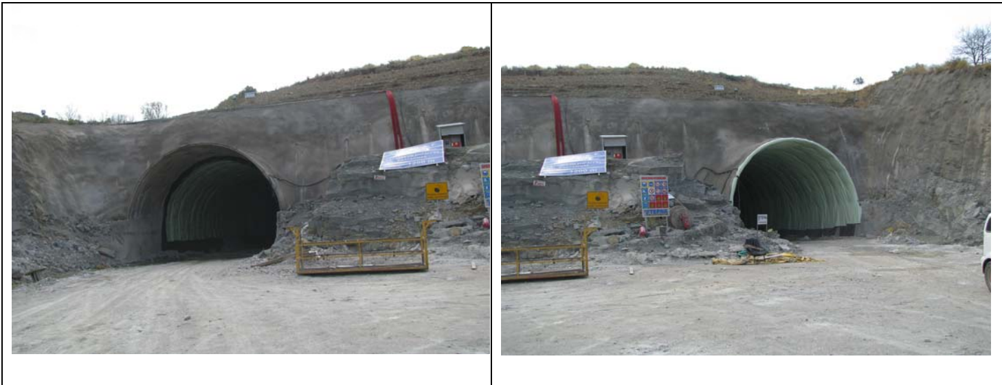
Φωτ.5.2 Στόμια εισόδου διαμόρφωση μετωπικού πρανούς (ΤΕΡΝΑ)
