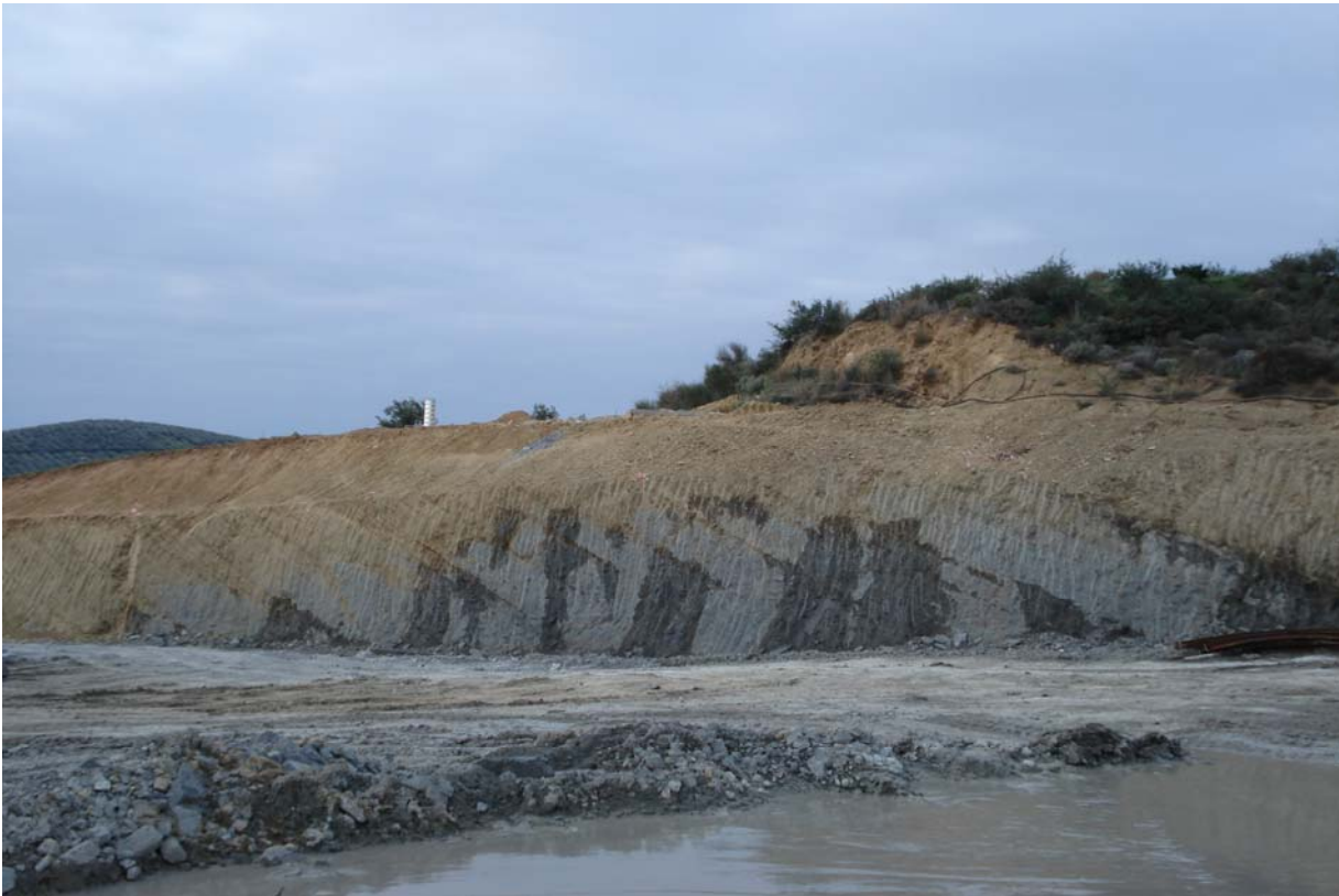
Φωτ.5.6 Στόμια εξόδου, δεξιό πρανάς εμφάνιση υδάτων στην επαφή ψαμμίτη-ιλυόλιθου
