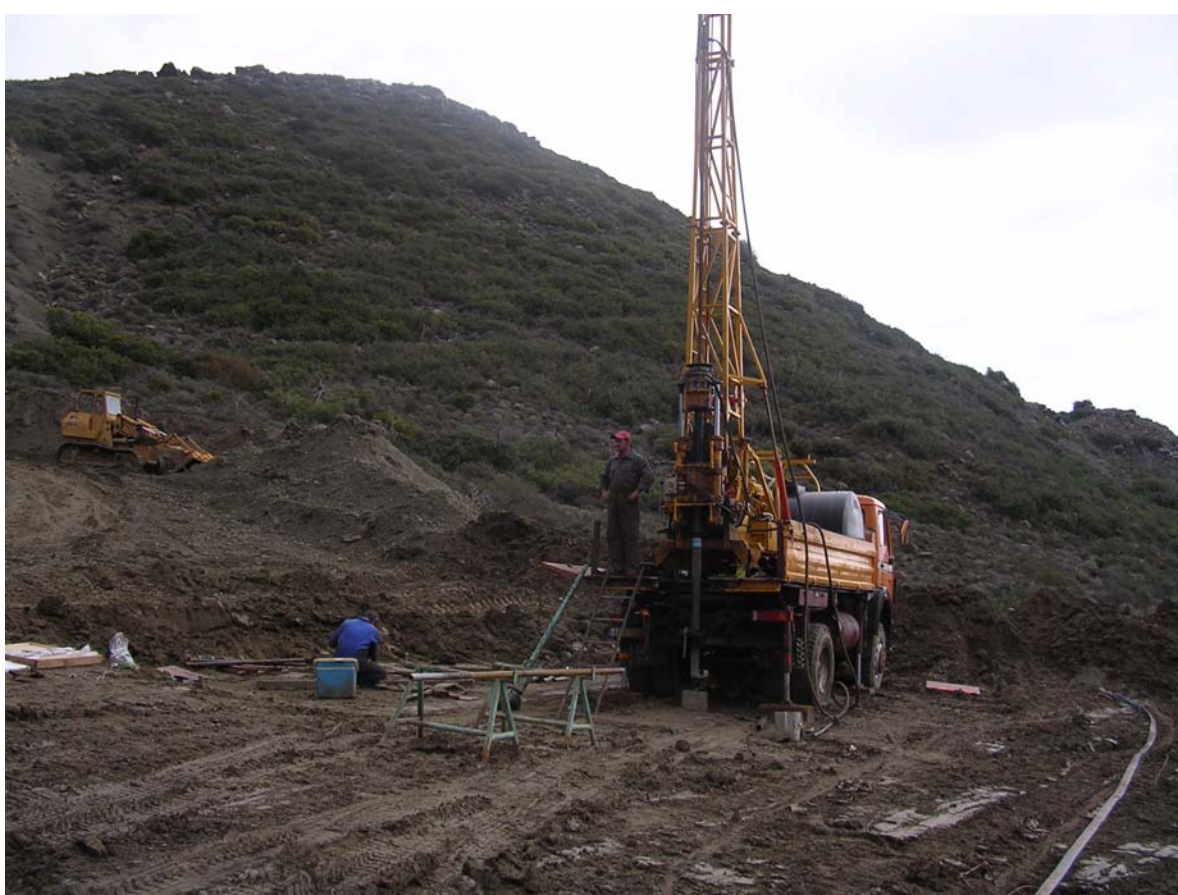
Εκτέλεση Γεώτρησης BT1-204
