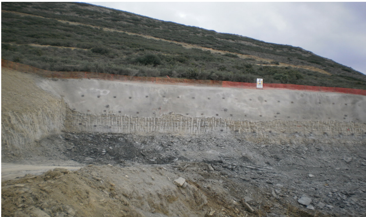
Φωτ.5.3 Στόμια εξόδου διαμόρφωση μετωπικού πρανούς (Ferrovial)
