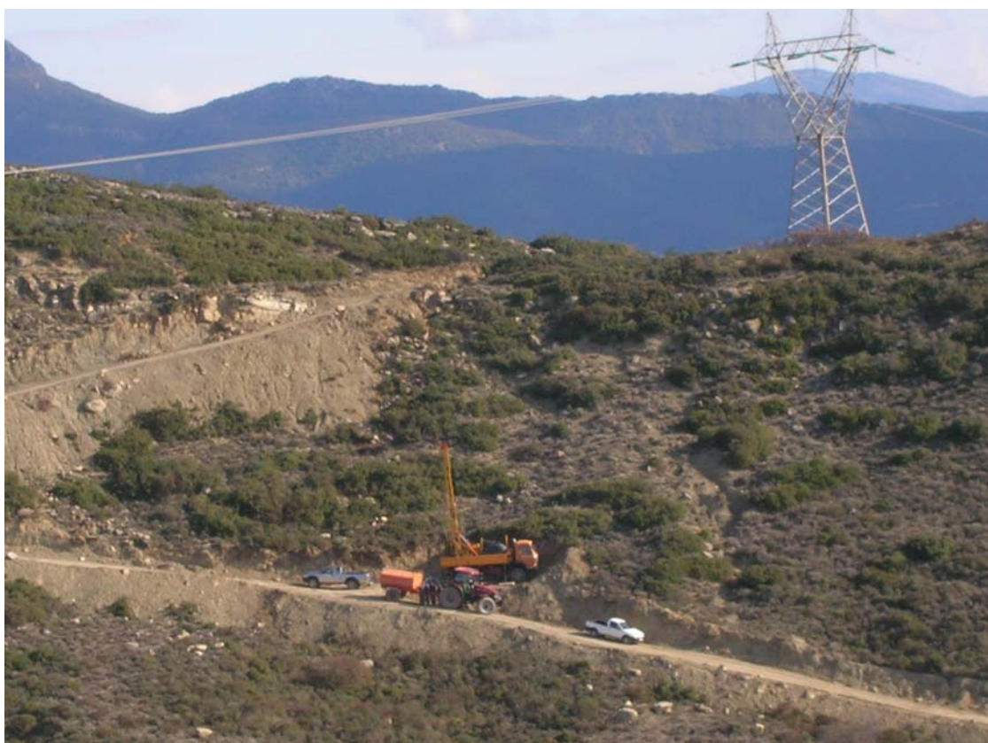
Εκτέλεση Γεώτρησης BT1-203A
