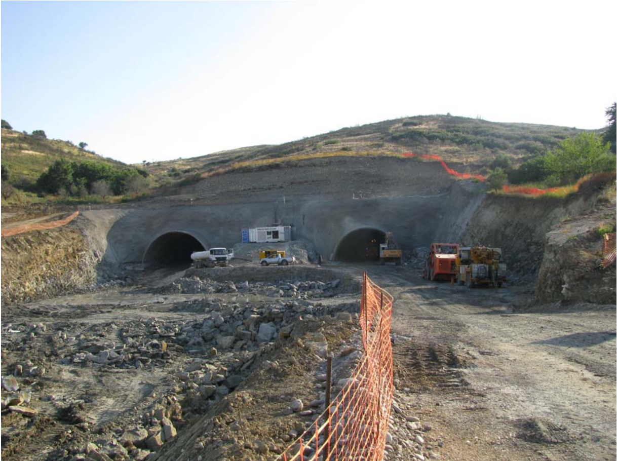
Φωτ.5.1 Στόμια εισόδου διαμόρφωση μετωπικού πρανούς (TEPNA)
