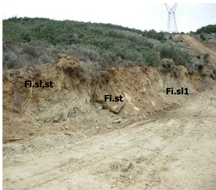
Περιοχή γεώτρησης BT1-203
