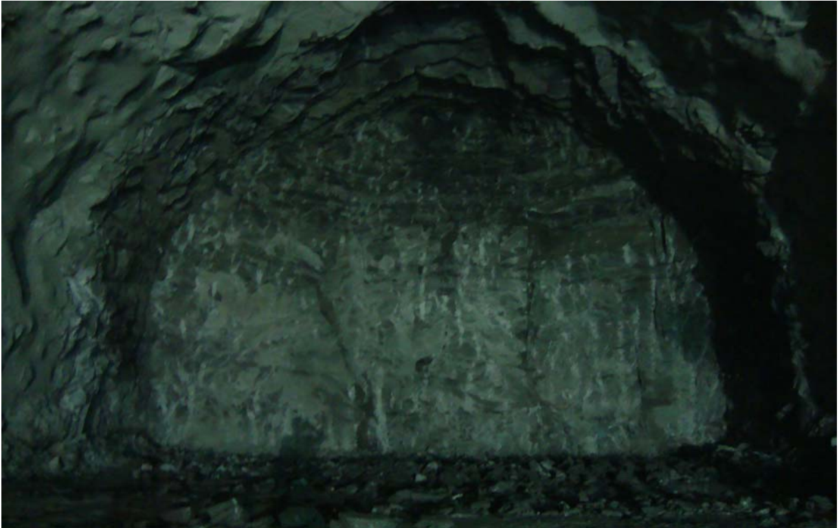
Φωτ. 7.1 Χ.Θ. 25+003 Κατηγορία βραχώμαζας Α (Δεξιός κλάδος)
