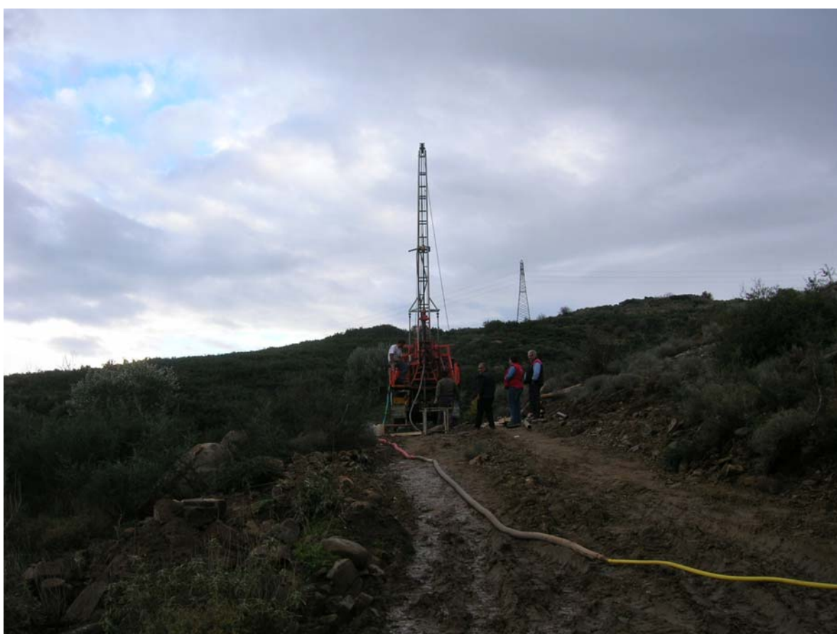
Εκτέλεση Γεώτρησης BT1-201
