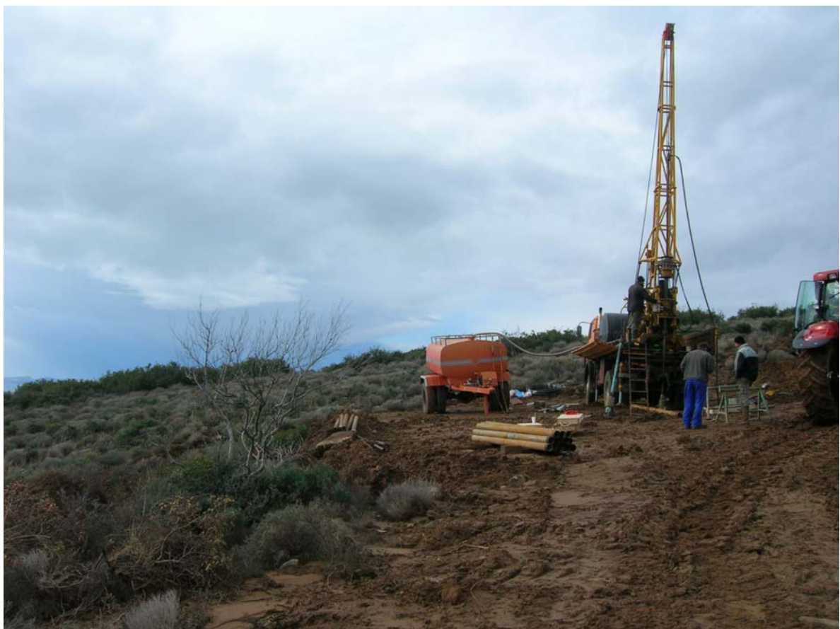
Εκτέλεση Γεώτρησης BT1-205
