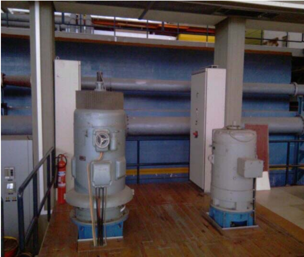
Εικόνα 57 – Οι όμοιες αντλίες που είναι συνδεδεμένες παράλληλα
