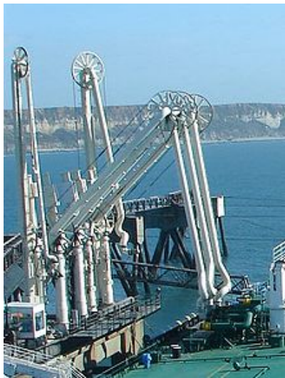
Εικόνα 3 - Νησίδα Φόρτωσης Δεξαμενόπλοιων
