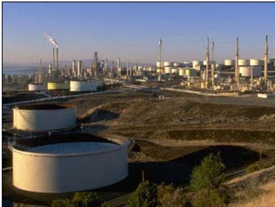
Εικόνα 1 - Δεξαμενές Αποθήκευσης Καυσίμου
