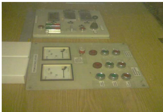
Εικόνα 56 - Πίνακας χειρισμού αντλιών και ρύθμισης στροφών
