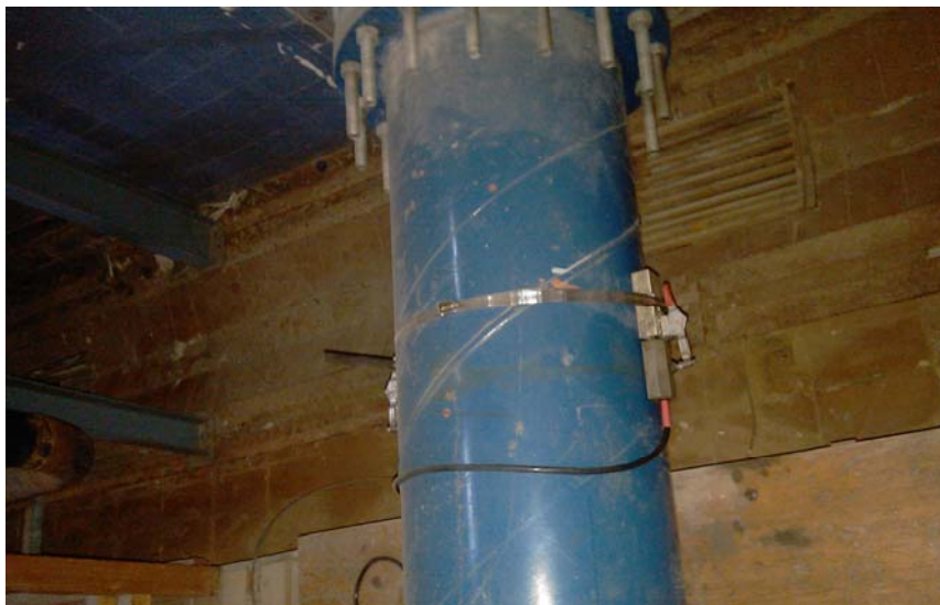
Εικόνα 61 – Μετρητής Υπερηχητικός - τύπου Clamp-On
