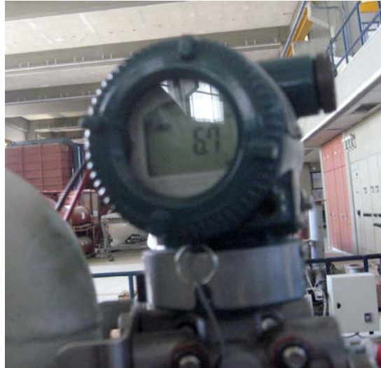
Εικόνα 58 - Διαφορικός μεταδότης πίεσης
