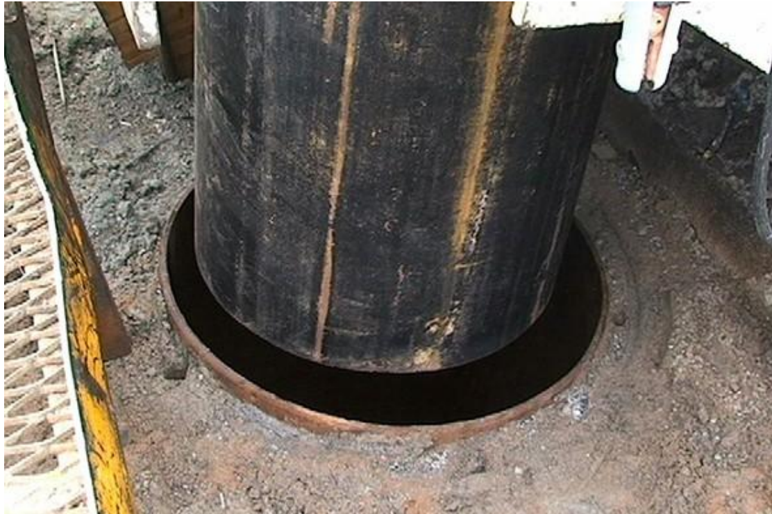
Εικόνα 7.12. Η χαλύβδινη επένδυση της σήραγγας διαφυγής. (Πηγή : Διαδίκτυο)
