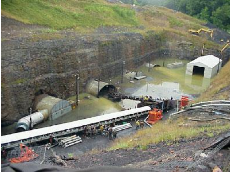
Εικόνα 2.12. Η κατάσταση που επικρατούσε στις εισόδους του ορυχείου Quecreek μετά τη διάρρηξη του μετώπου και την είσοδο του νερού σε αυτό. (Πηγή : Διαδίκτυο)
