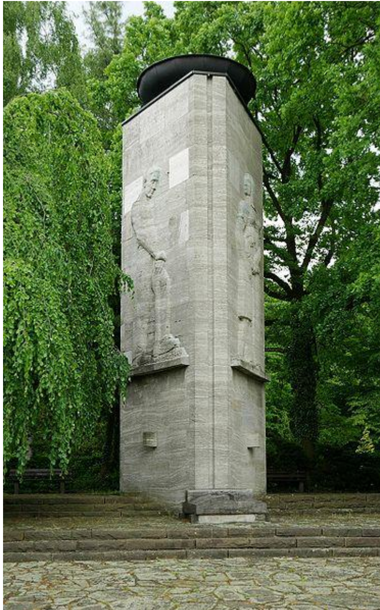
Εικόνα 2.8. Κατασκευή εις μνήμην των μεταλλωρύχων που έχασαν τη ζωή τους στο ατύχημα του 1946. (Πηγή : Διαδίκτυο)
