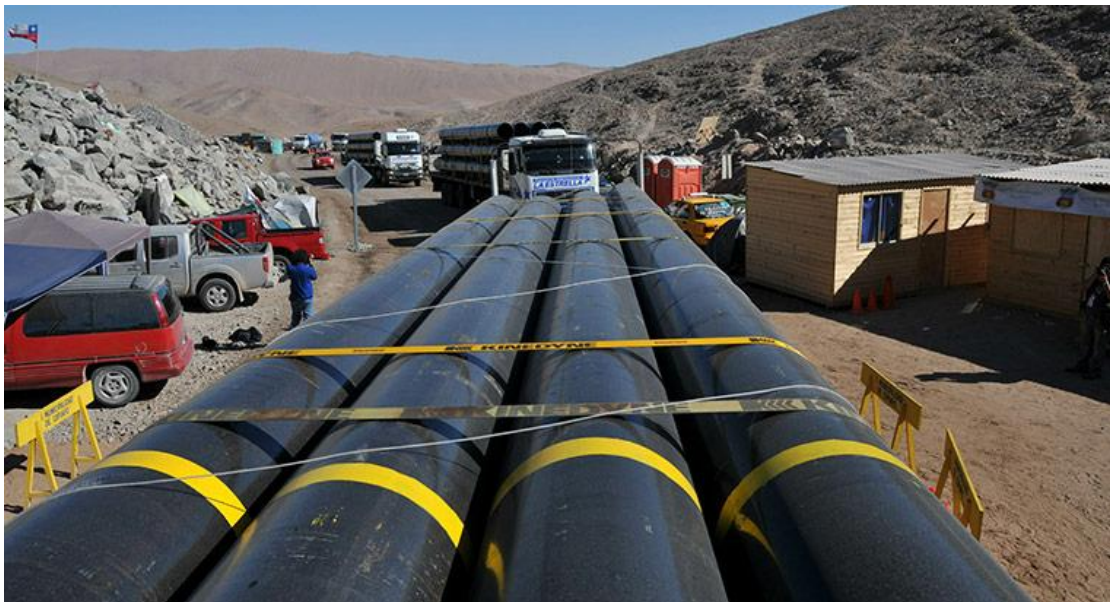
Εικόνα 3.16. Οι αγωγοί επένδυσης φτάνουν στο εργοτάξιο του ορυχείου. (Πηγή : Διαδίκτυο)
