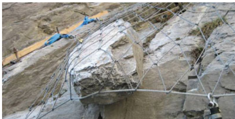
Εικόνα 2.4. Πλέγμα συγκράτησης βραχοτεμαχίων (πηγή Geobrugg)
