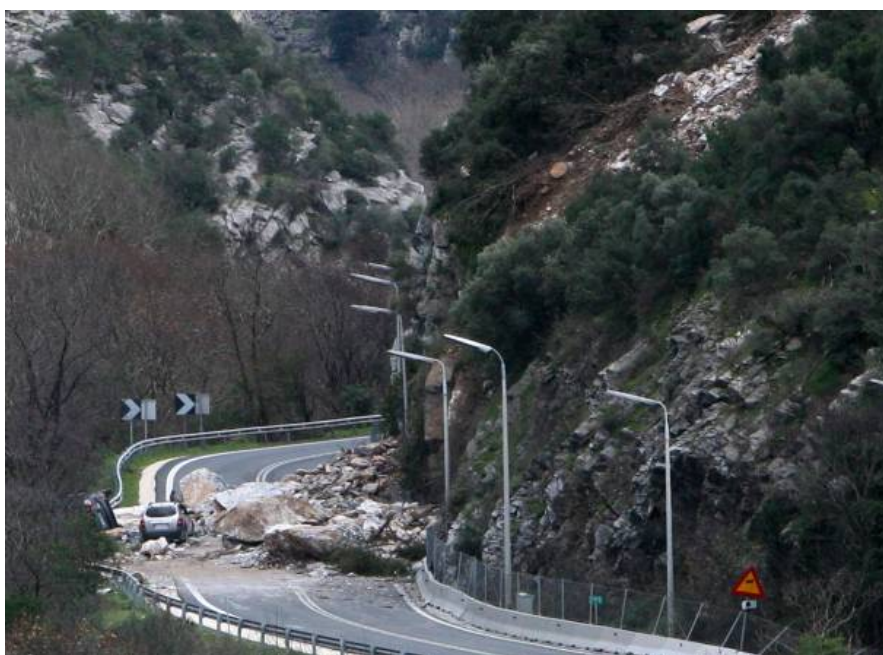
Εικόνα 2.1. Άποψη από την κατάπτωση βράχων στο εθνικό οδικό δίκτυο, στην κοιλάδα των Τεμπών (Δεκέμβριος 2009)
