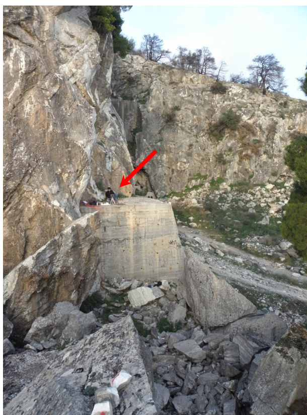
Εικόνα 5.3. Θέση εγκατάστασης μηχανής ταχείας λήψης.
