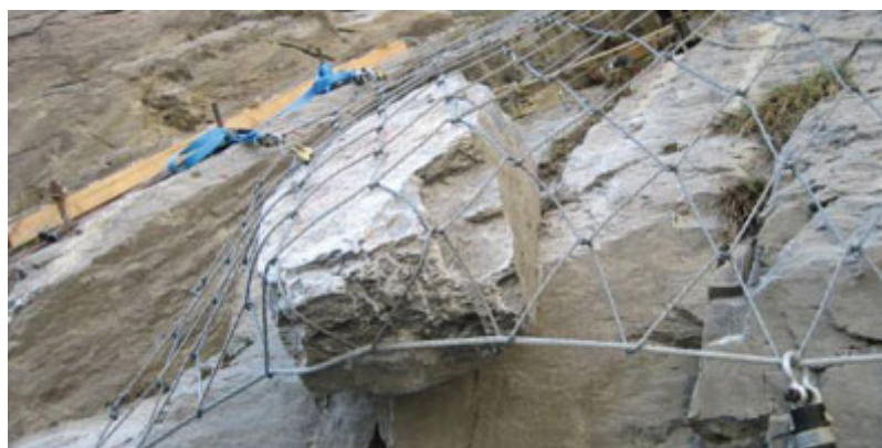
Εικόνα 2.4. Πλέγμα συγκράτησης βραχοτεμαχίων (πηγή Geobrugg)
