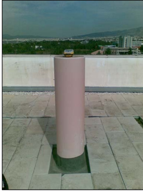
Φωτ. 3.11: Κτήριο Βέη με ενσωματωμένη κεραία
