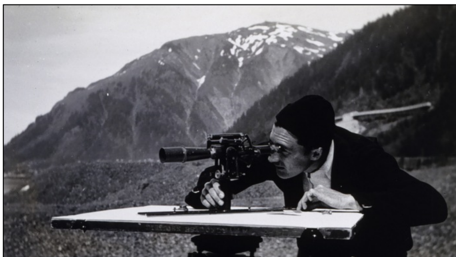
Φωτ. 1.1: Αποτύπωση με μετροτράπεζα
