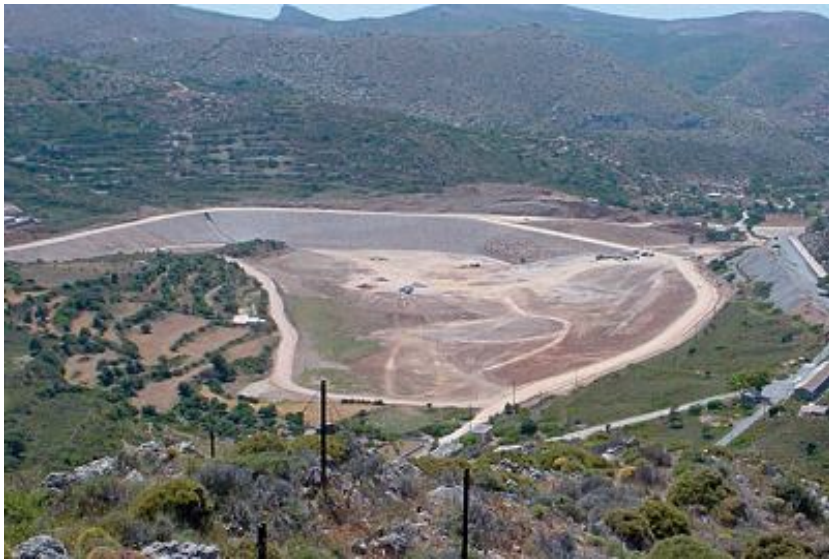
Εικόνα 4.49: Άποψη του φράγματος Παρθενίου κατά τη διάρκεια της κατασκευής (Πηγή: ΥΠΑΑΤ)
