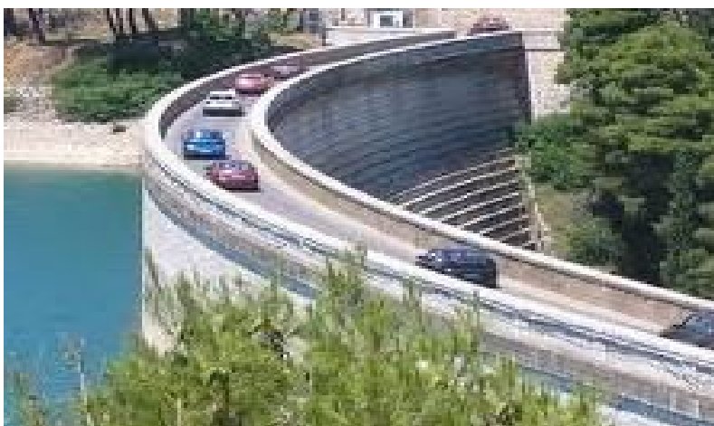
Εικόνα 4.28: Φράγμα Μαραθώνα (Πηγή: panoramio.com)
