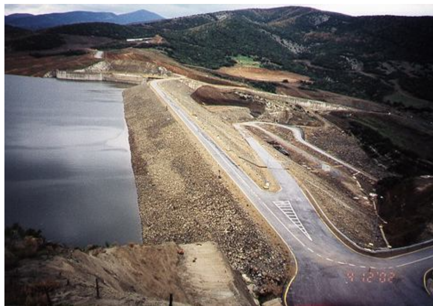
Εικόνα 4.36: Φράγμα Γρατινής Ν. Ροδόπης (Πηγή: ΤΕΡΝΑ Α.Ε.)
