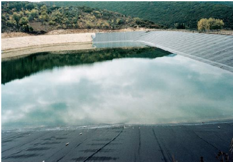
Εικόνα 4.23: Λιμνοδεξαμενή Καρυάς Λευκάδας (Πηγή: ΥΠΑΑΤ)
