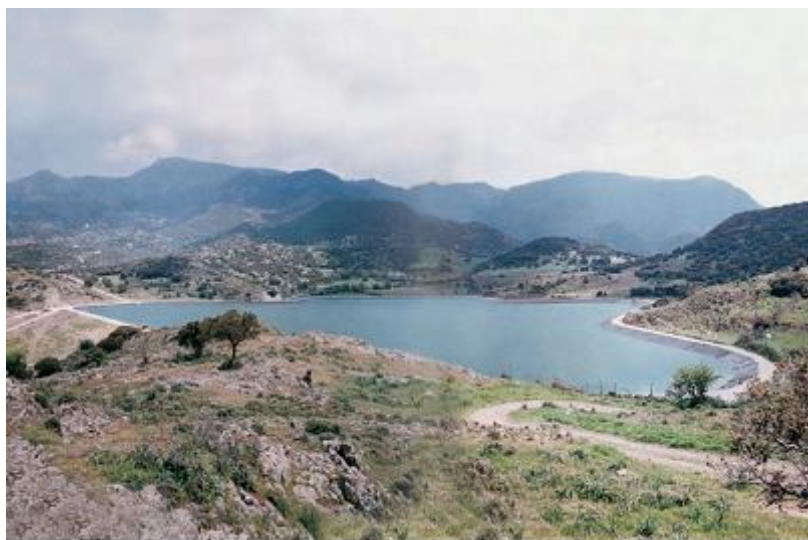
Εικόνα 4.60: Λιμνοδεξαμενή Μήθυμνας Λέσβου (Πηγή: ΥΠΑΑΤ)
