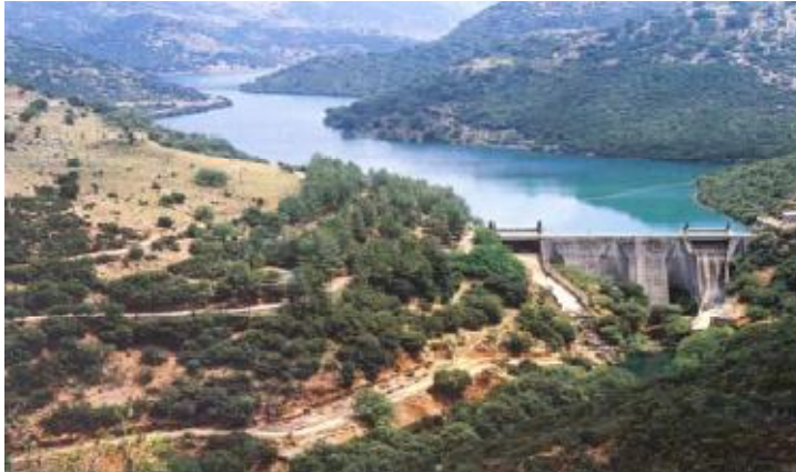
Εικόνα 4.16: Φράγμα Λάδωνα (Πηγή: ΔΕΗ)
