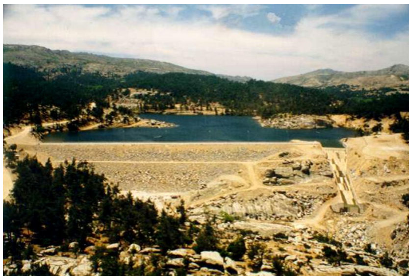
Εικόνα 4.50: Φράγμα και Ταμιευτήρας στις Ράχες Ικαρίας (Πηγή: ΥΠΑΑΤ)
