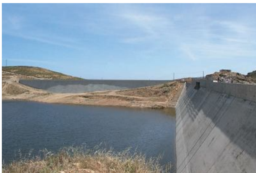
Εικόνα 4.51: Φράγμα RCC στο χείμαρρο Στενό Σερίφου Κυκλάδων (Πηγή: ΥΠΑΑΤ)
