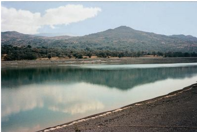
Εικόνα 4.38: Λιμνοδεξαμενή Βιζαρίου Ρεθύμνου (Πηγή: ΥΠΑΑΤ)
