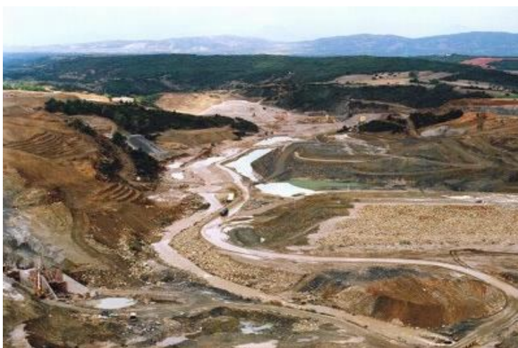
Εικόνα 4.17: Υπό κατασκευή Φράγμα Πείρου (πηγή: Internet - The Best News)
