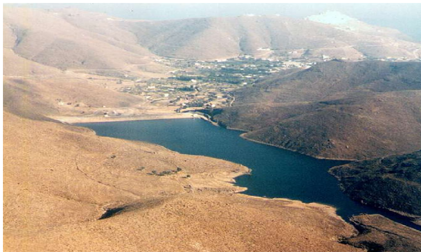
Εικόνα 4.45: Φράγμα Λειβαδίου Αστυπάλαιας (Πηγή: ΥΠΑΑΤ)
