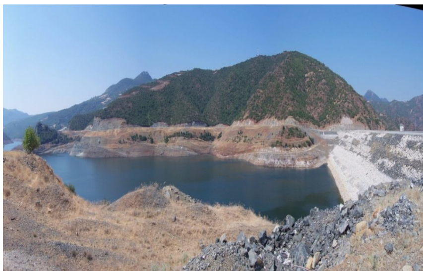
Εικόνα 4.32: Φράγμα και ταμιευτήρας Σμοκόβου (Πηγή: www.panoramio.com )
