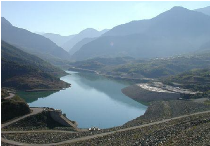
Εικόνα 4.20: Φράγμα Αγίου Δημητρίου στον Εύηνο ποταμό (Πηγή: Ε.Α. Δημητρίου, 2006)
