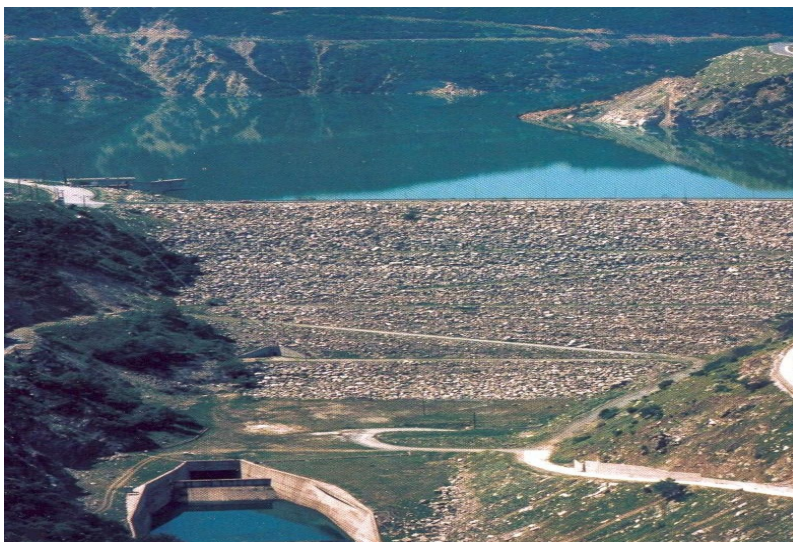
Εικόνα 4.33: Φράγμα Πολυφήτου (Πηγή: ΔΕΗ)
