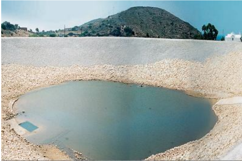
Εικόνα 4.62: Λιμνοδεξαμενή Παναγιάς Λειψών – Δωδεκάνησα (Πηγή: ΥΠΑΑΤ)
