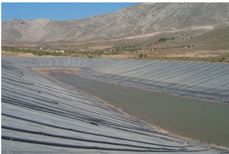
Εικόνα 4.56: Λιμνοδεξαμενή στο Βαθύ Καλύμνου (Πηγή: ΥΠΑΑΤ)
