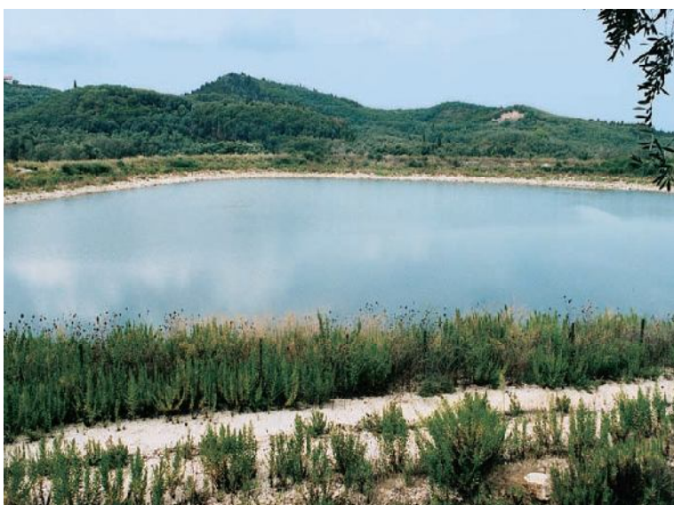
Εικόνα 4.26: Λιμνοδεξαμενή Μοσχόπουλου Κέρκυρας (Πηγή: ΥΠΑΑΤ)
