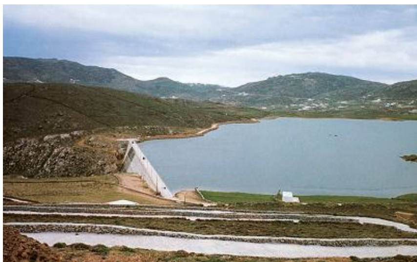
Εικόνα 4.46: Ταμιευτήρας και Φράγμα Μαραθίου Μυκόνου (Πηγή: ΥΠΑΑΤ)
