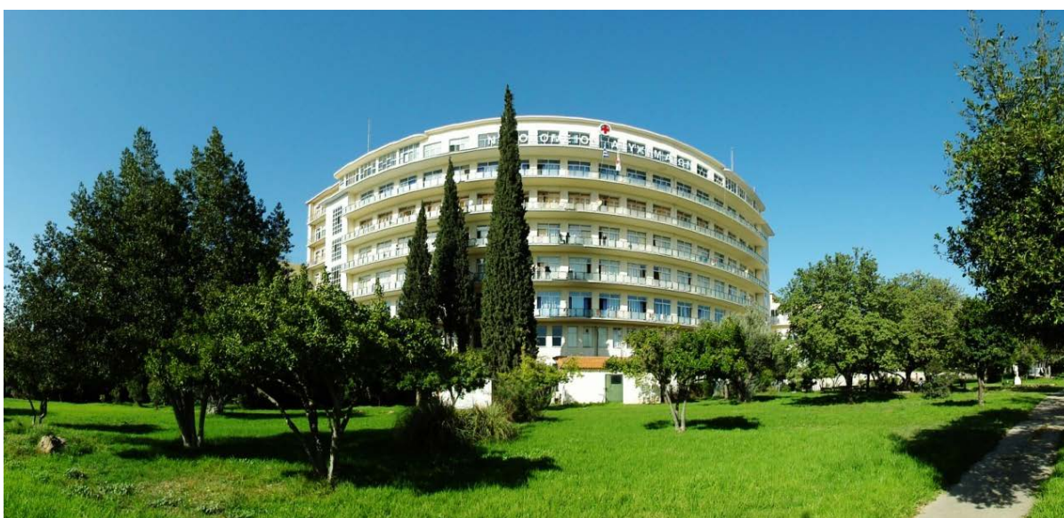
Εικόνα 4.2 Πρόσοψη νοσοκομείου ΚΑΤ (πηγή: http://www.themeli.gr/techworksgr.php )
