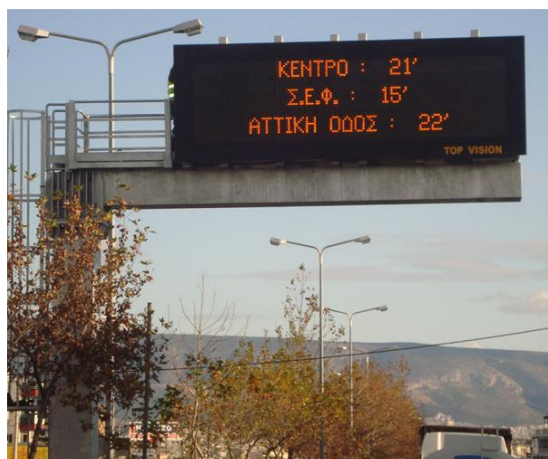
Εικόνα 2.6: Σταθερή πινακίδα μεταβλητών μηνυμάτων
