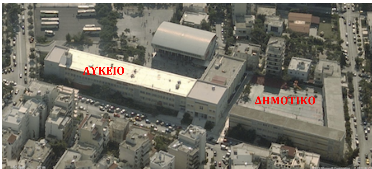
Εικόνα 13: Βορεινή πλευρά των κτιρίων του Λεοντείου Λυκείου Νέας Σμύρνης. Αριστερά διακρίνεται το Λύκειο και δεξιά το Δημοτικό.
