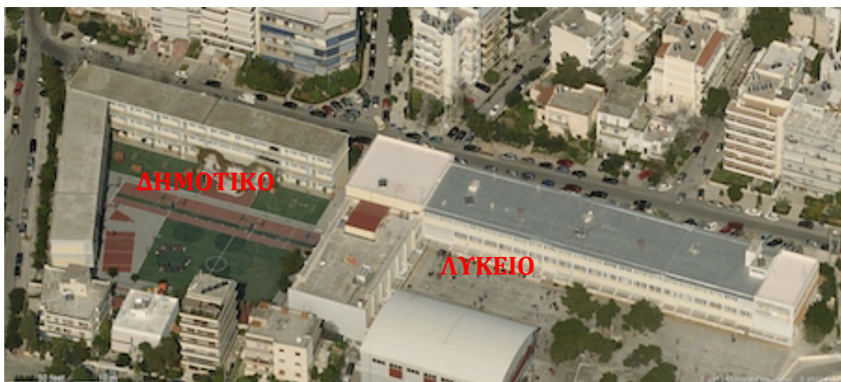
Εικόνα 12: Νότια πλευρά των κτιρίων του Λεοντείου Λυκείου Νέας Σμύρνης. Δεξιά ξεχωρίζει το Λύκειο και αριστερά το Δημοτικό.
