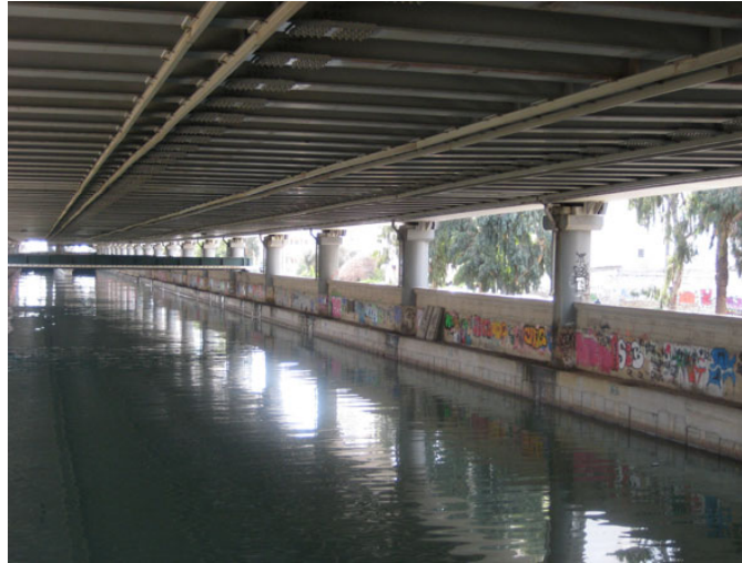
Εικόνα 1.3: Διευθετημένο τμήμα Κηφισού Ποταμού με ανοίγματα στα πλάγια στην περιοχή του Μοσχάτου 4
