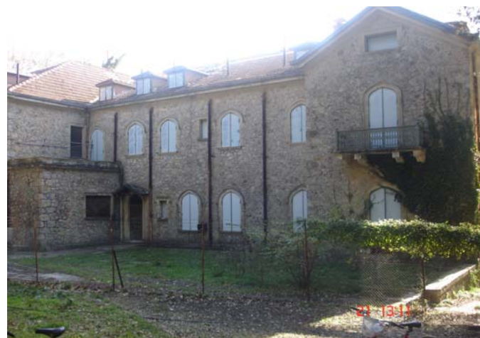
Εικόνα 2.15: Τατόι, Πρώην Βασιλικό Κτήμα, Το Κτίριο Διοίκησης
