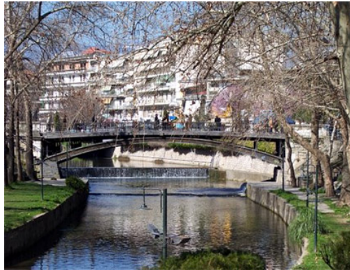
Εικόνα 3.2: Τρίκαλα, Πεζογέφυρα στον Ποταμό Ληθαίο
