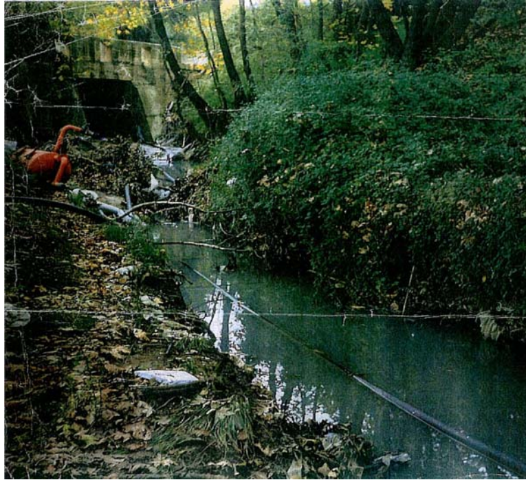
Εικόνα 2.5: Άνοιξη, Παράνομη Σύνδεση Όμβριων στον Κηφισό (Αρχείο Π. Τσίτουρα)
