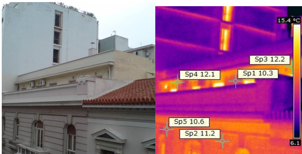
Εικόνα 4.6 : Δεύτερος και τρίτος όροφος (Πρόσοψη)
