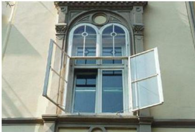
Εικόνα 2.2: Παράθυρο με πρόσθετη εγκατάσταση εσωτερικού φύλλου [5]
