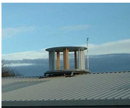
Εικόνα 2.3: Ανεμογεννήτρια εγκατεστημένη σε οροφή κτιρίου [7]
