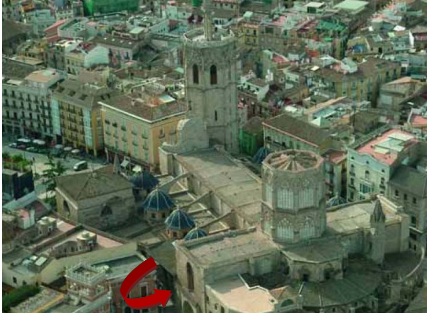
Εικόνα 2.5 : Αεροφωτογραφία του Καθεδρικού Ναού της Βαλένθια
