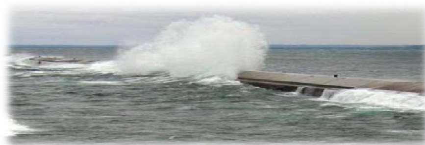
Εικόνα 2.1: Αναρρίχηση, Υπερπήδηση και Μετάδοση Κύματος σε χαμηλής στέψης έργα.
