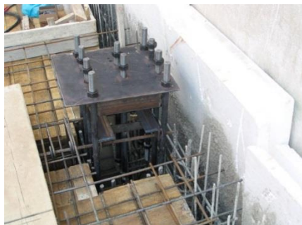
Σχήμα 1.9: Έδραση υποστύλωματος με τη μορφή πάκτωσης.
