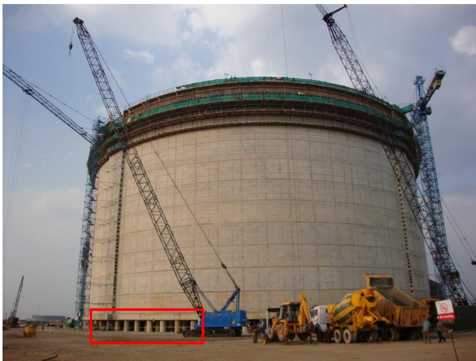
Σχήμα 1.17α: Δεξαμενή θεμελιωμένη με πασσάλους.
