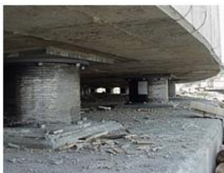
Σχήμα 1.17β: Δεξαμενή θεμελιωμένη σε πλάκα με εφόδρανα.
