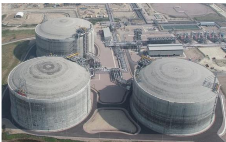
Σχήμα 1.15: Υπέργεια δεξαμενή πλήρης συγκράτησις
