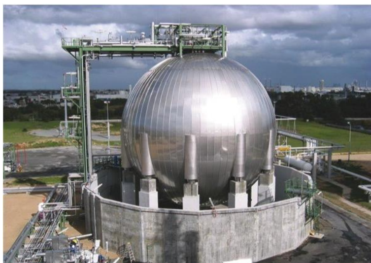
Σχήμα 1.16: Υπέργεια σφαιρική δεξαμενή αποθήκευσις, όχι ΥΦΑ
