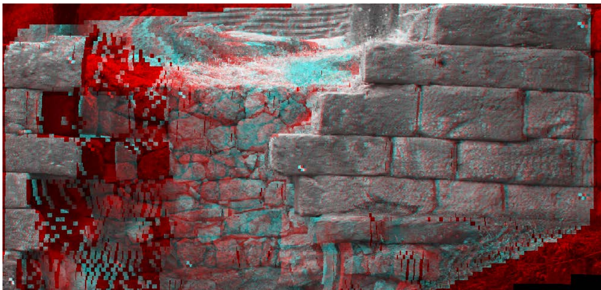
Εικόνα 6-12: Εικόνα αναγλύφου τμήματος του αναλημματικού τοίχου (περιοχή II)
