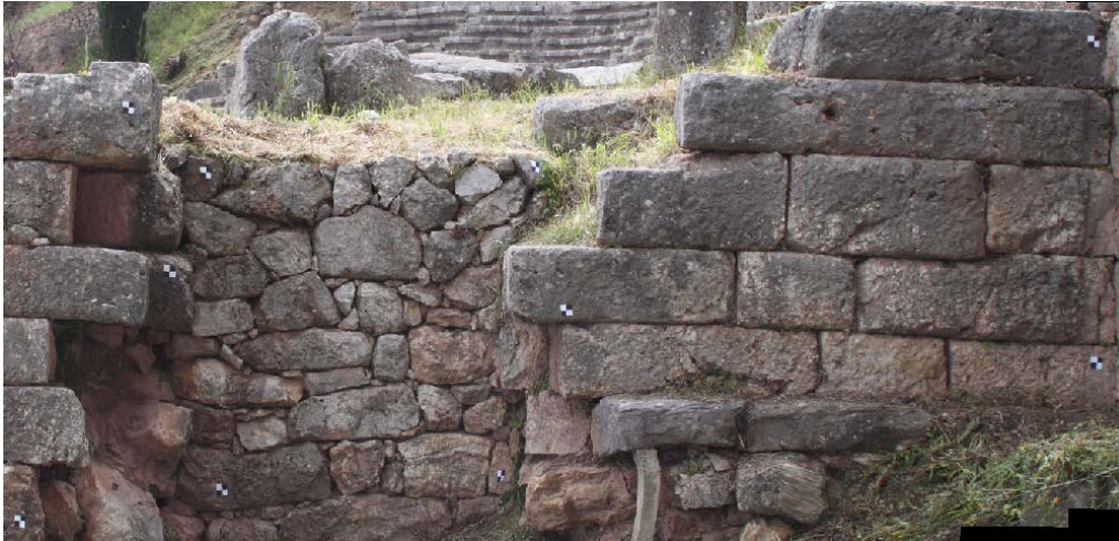
Εικόνα 6-9: Ορθοεικόνα τμήματος του αναλημματικού τοίχου του Θεάτρου Δελφών (περιοχή II)
