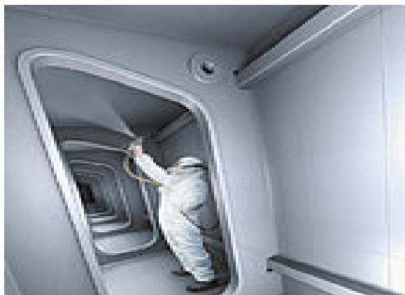
Εικόνα 3.6 Τελικό επίχρισμα εσωτερικά σε χώρο πλοίου.
