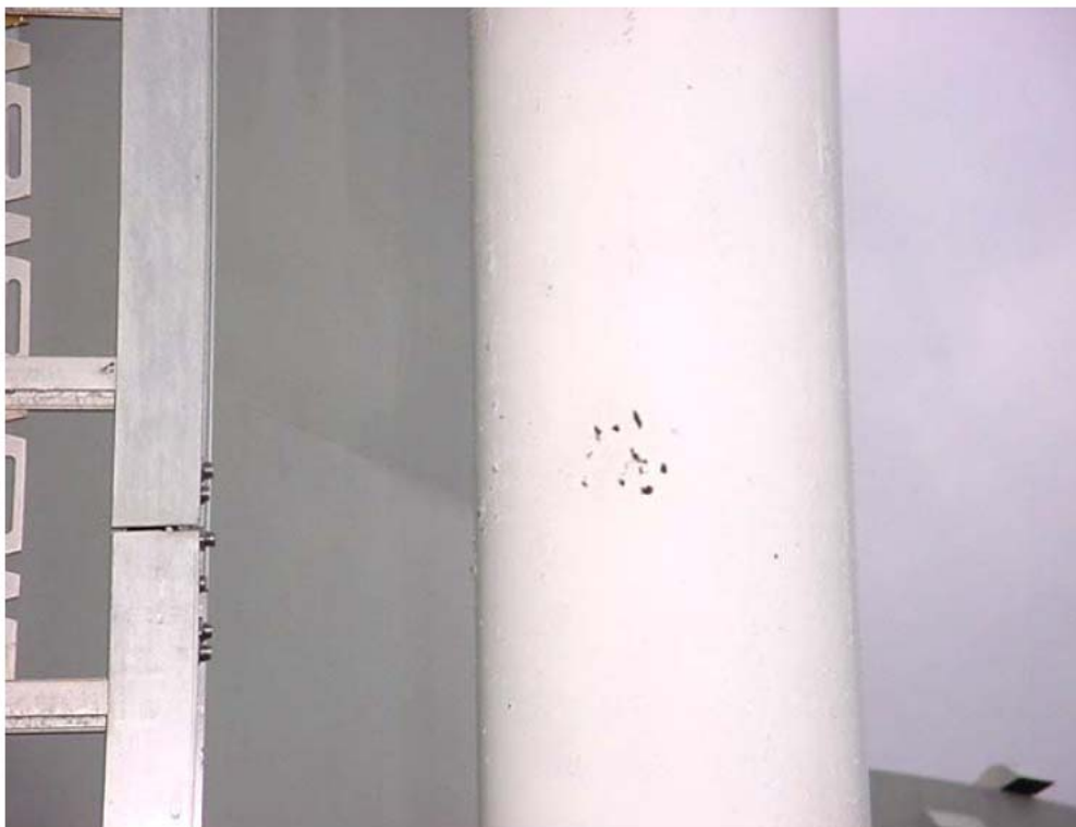
Εικόνα 6.1 Αποφλοίωση χρώματος από αγωγό http://www.stoprust.com/3coatingfailures.htm
