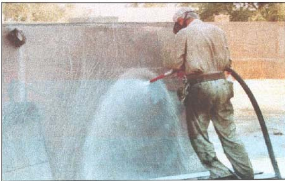
Εικόνα 4.4 Υδροαμμοβολή με μέθοδο έγχυσης αποξεστικών http://library.tee.gr
