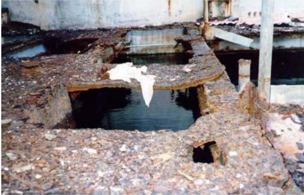
Εικόνα 1.24 Περιβαλλοντική Διάβρωση.
