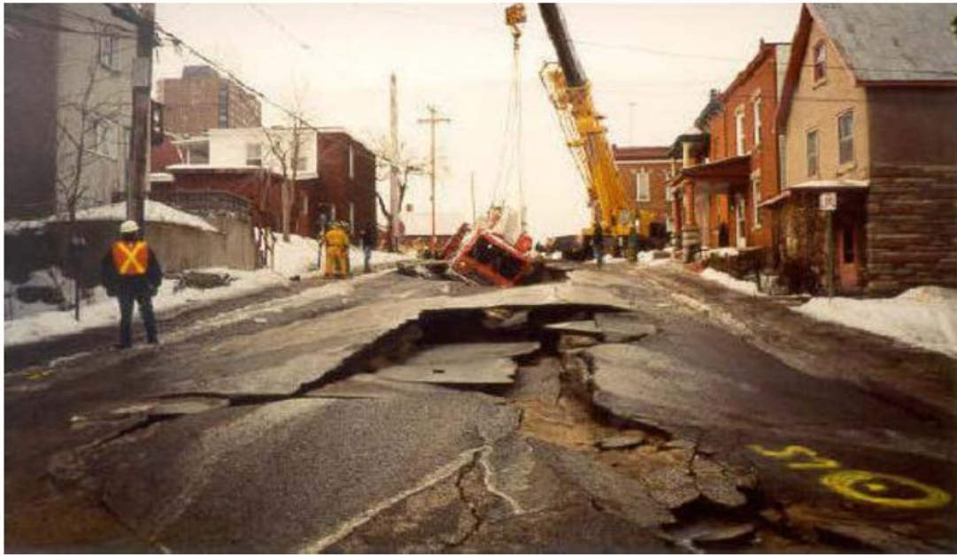
Εικόνα 1.25 Διάβρωση εδάφους λόγω έντονων θερμοκρασιακών αλλαγών http://www.corrosionist.com
