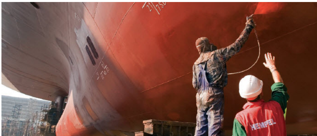
Εικόνα 3.8 Διαδικασία περάσματος τελικού επιχρίσματος στο εξωτερικό περίβλημα πλοίου.
