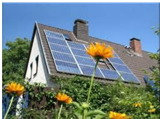
Σχήμα 5.4: Φωτοβολταϊκά στις στέγες
