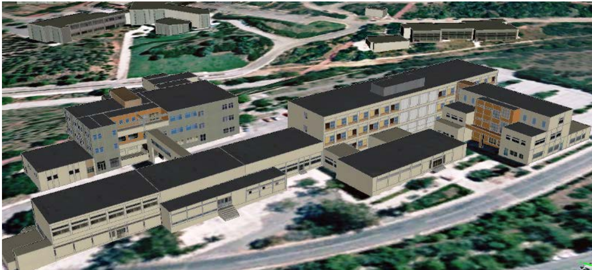
Εικόνα 5.25: Άποψη των κτηρίων της Σχολής Αγρονόμων και Τοπογράφων Μηχανικών
