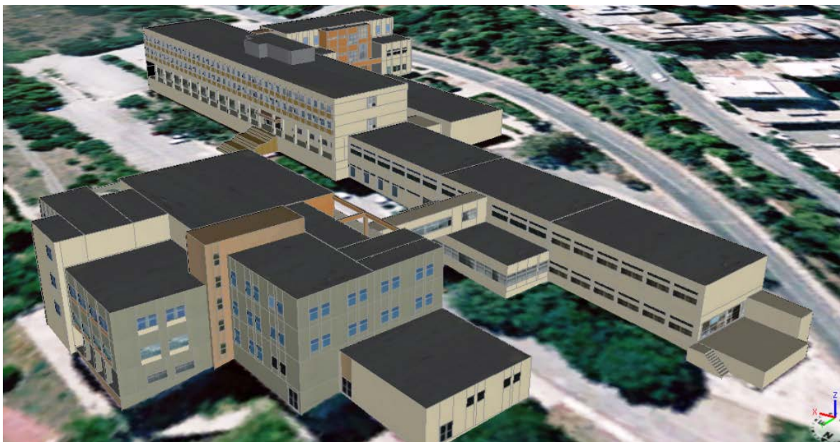
Εικόνα 5.26: Άποψη των κτηρίων της Σχολής Αγρονόμων και Τοπογράφων Μηχανικών
