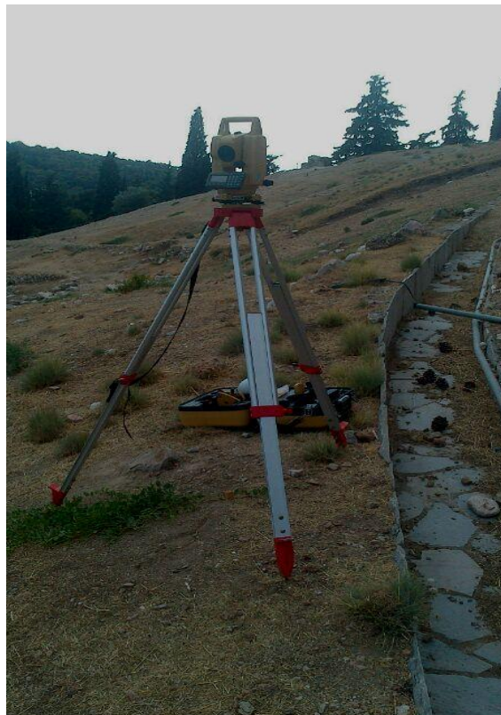
Εικόνα 50: Μετρήσεις με Total Station στην S2
