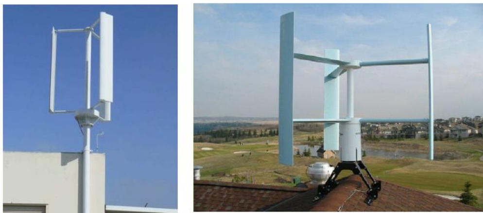
Σχήμα 29: Εγκατεστημένες ανεμογεννήτριες σε οικία [35]
