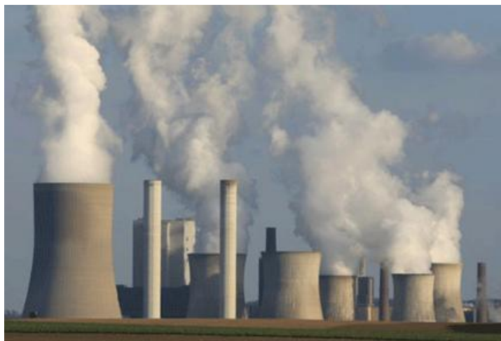
Σχήμα 1: Εκπομπές ρύπων από εργοστάσια [1]
