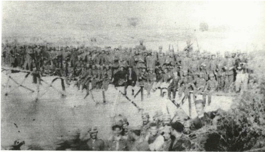
11/10/1912. Πρόχειρη ξύλινη γέφυρα στον Αλιάκιονα μήκους 130 μέτρων που κατασκευάστηκε από τον ελληνικό στρατό σε δύο ώρες. Τμήμα του ελληνικού στρατού με Βελβεντινούς και Σερβιώτες μετά την κατασκευή της γέφυρας στον Αλιάκιονα, κοντά στο χωριό Χείμπελι (σήμερα Ίμερα).
