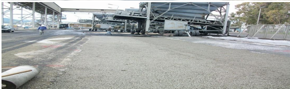
Εικόνα 103. Η έκταση που διαστρώθηκε πριν (α)- μετά (β) με διαπερατό σκυρόδεμα σε εργοστασιακό χώρο στην Ελευσίνα.
