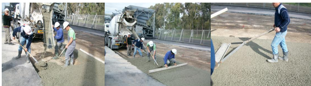
Εικόνα 102. Στάδια διάστρωσης διαπερατού σκυροδέματος
