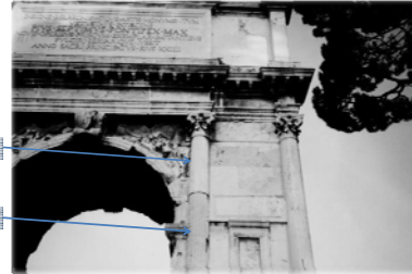
Arch of Titus, Ρώμη Πριν και μετά την αποκατάσταση
