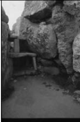
1994: Κατάρρευση τμήματος των ναών Μhajdra Temples μετά από ισχυρή βροχόπτωση
