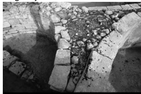
Λεπτομέρεια διπλής τοιχοποιίας και πλήρωσης
