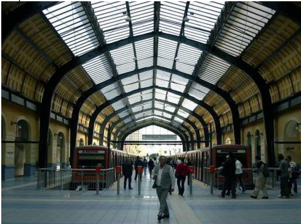
Σχήμα 1.5: Άποψη του μεταλλικού στεγάστρου από το εσωτερικό του σταθμού
