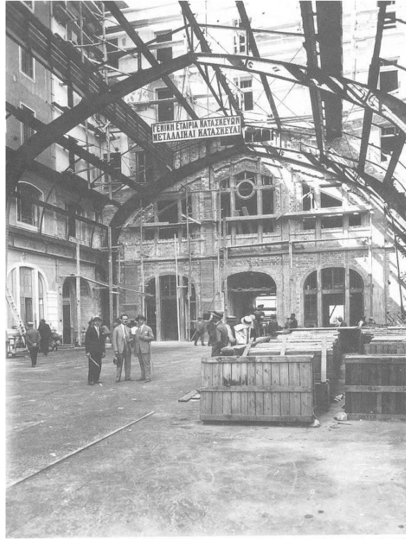
Σχήμα 1.6: Το στέγαστρο υπό κατασκευή το 1926
