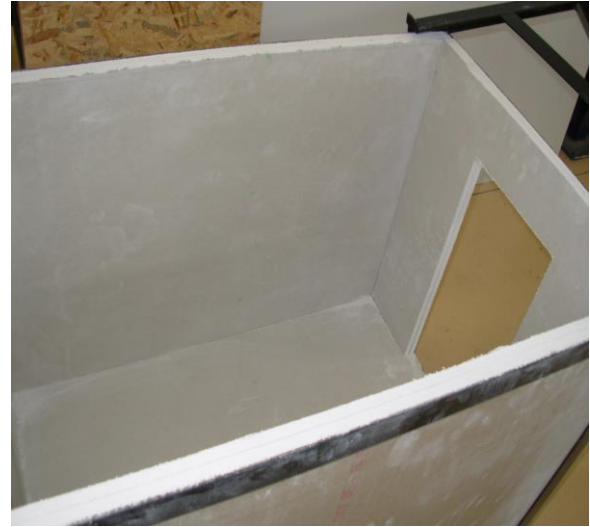
Σχήμα 3.7 Εσωτερικό του δωματίου, μετά την τοποθέτηση των πλαινών και του δαπέδου γυψοσανίδων
