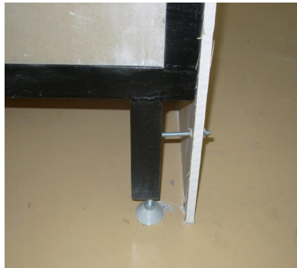
Σχήμα 3.11 Φωτογραφία στηρίγματος κατασκευής και βίδωμα πρόσοψης σε αυτό
