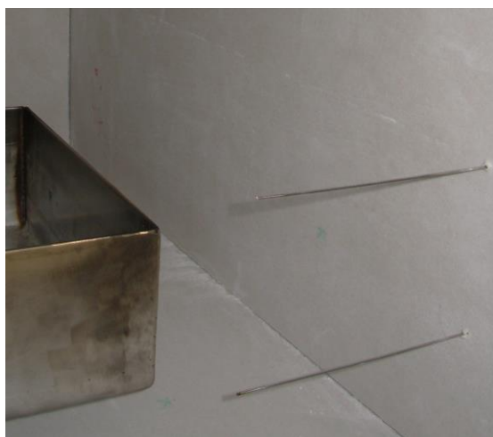
Σχήμα 3.16 Τα θερμοστοιχεία στο εσωτερικό του δωματίου
