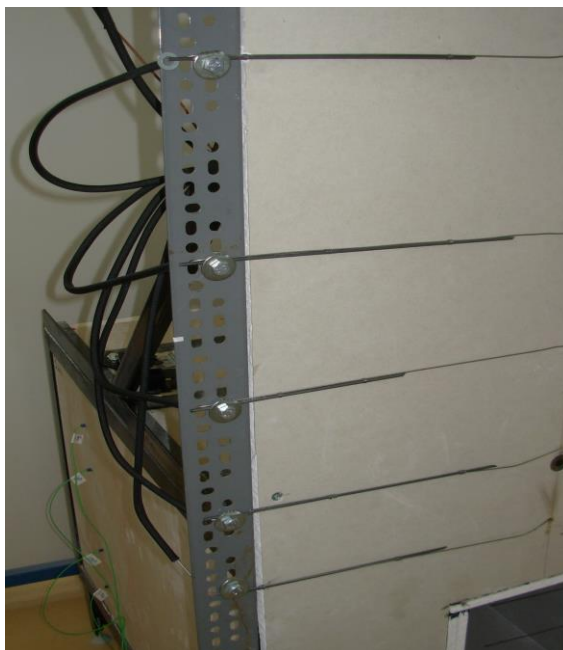
Σχήμα 3.18 Στήριξη θερμοστοιχείων στην πρόσοψη, πάνω στη στήλη ‘ντέξιον’
