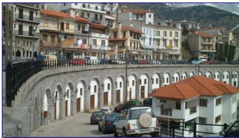
Εικόνα 6: πολλές ανεξάρτητες ιδιοκτησίες κάτω από την γέφυρα της Αράχοβας (Πηγή: Παπαευθυμίου, 2004)
