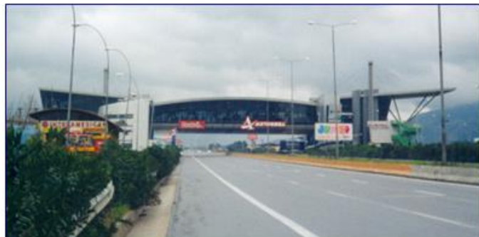
Εικόνα 3: εναέρια κατασκευή πάνω από εθνική οδό (Πηγή: Παπαευθυμίου, 2004)
