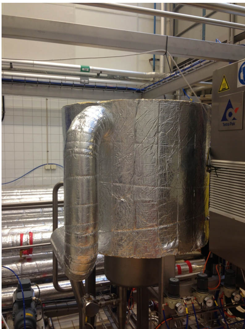
Εικόνα 16: Δεξαμενή φέροντος ρευστού (Liquid Tank)
