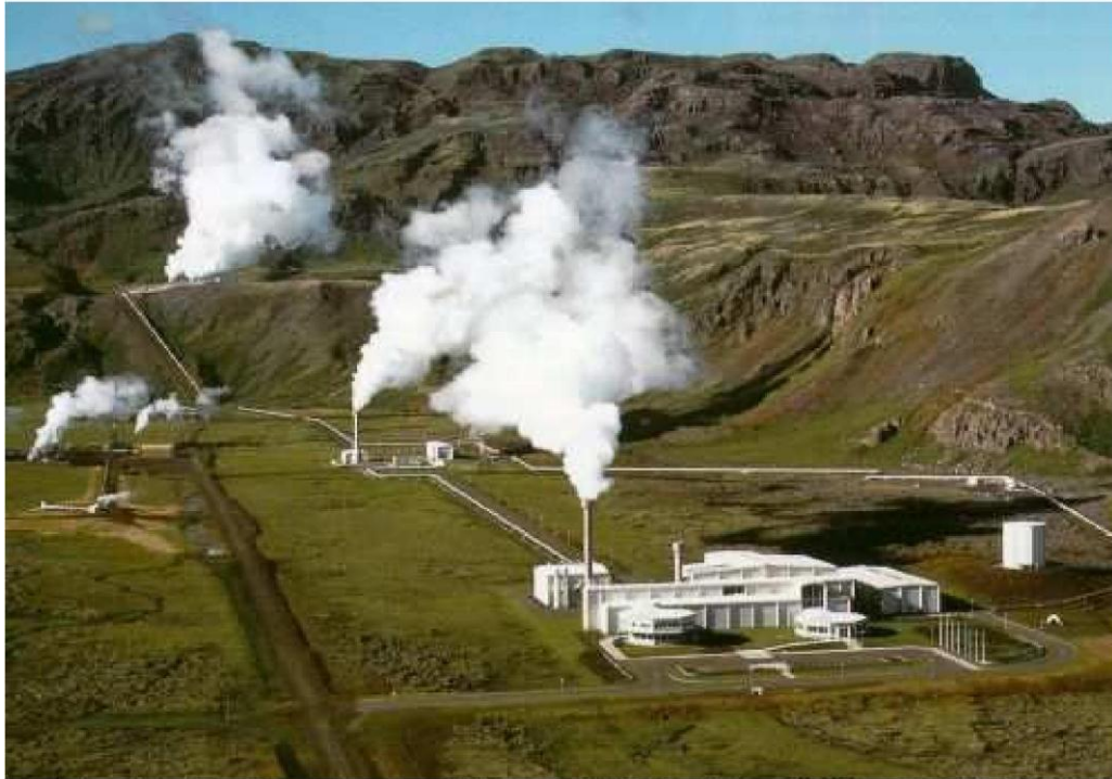
Εικόνα 16-Εργοστάσιο παραγωγής ηλεκτρικής ενέργειας από γεωθερμία, στο Nesjavellir στην Ισλανδία
